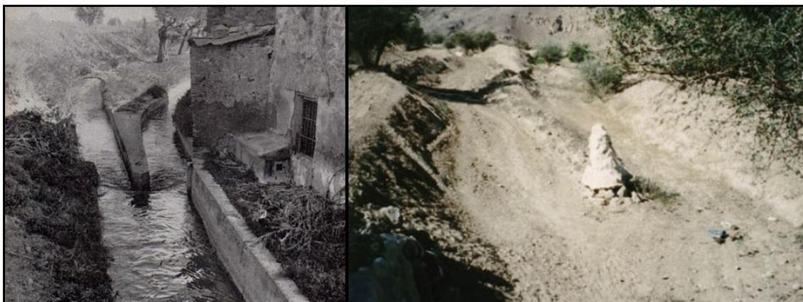
**Fig. 1.** A la izquierda partidor proporcional en la acequia de Tormos (huerta de Valencia) en 1956. A la derecha un partidor proporcional mucho más simple en un canal seco del valle de Hadramawt (Yemen).
