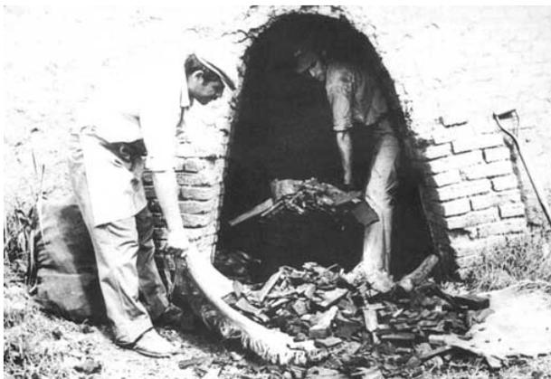
Figura 10. *Couadors* encargados del mantenimiento del fuego a principio del siglo XX, en un horno en Alaquàs (Ladrillera de Vinalesa)
