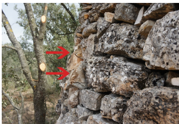
Figura 10. Criterio empleado en la reconstrucción y reparación, basado en el retranqueo de hiladas respecto a la estructura original (autores)
