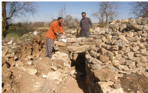
Figura 8. Reconstrucción de volúmenes perdidos del cobijo ES83 (autores)
