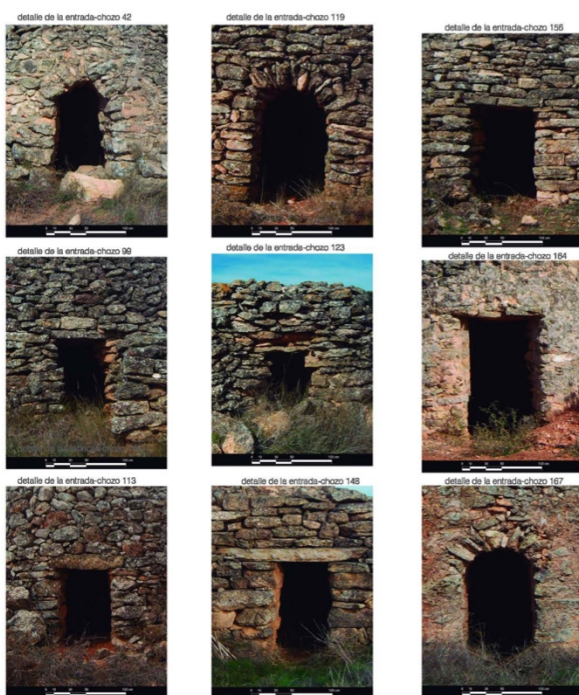
Figura 2. Levantamiento y caracterización de los vanos de acceso y de los dinteles de los cobijos estudiados (autores)
