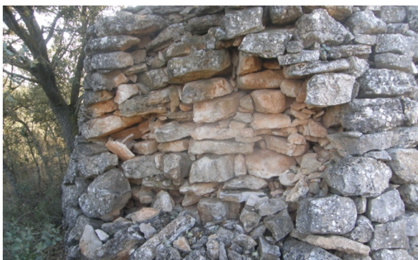
Figura 6. Ejemplo de lagunas, desprendimientos y volúmenes alterados en uno de los cobijos intervenidos (autores)
