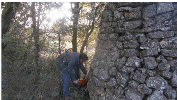
Figura 5. Proceso de desbroce, excavación y limpieza del contexto más cercano de uno de los cobijos intervenido (autores)
