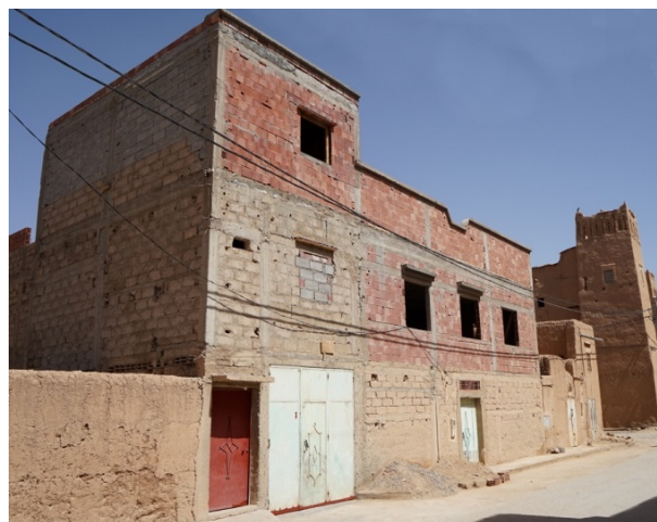
Figura 7. Vivienda del tercer periodo, actualmente en construcción en la que se observa el uso de los nuevos materiales.
