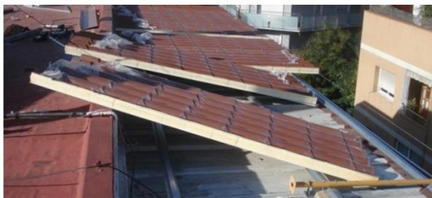
Figura 4. Ejemplos de rehabilitación energética. Cubierta inclinada, Panel prefabricado de cubierta. Imperquezada S.L.
