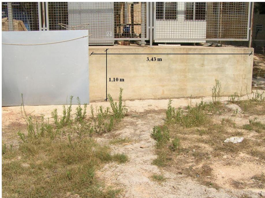
Figura 4.17.- Dimensiones y disposición del muro de hormigón
