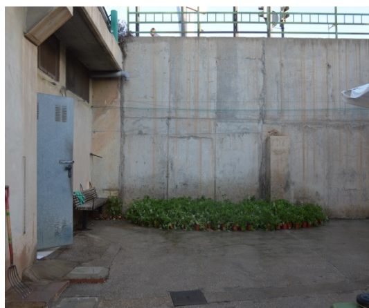
Patio de dependencias con planta para reposiciones.
