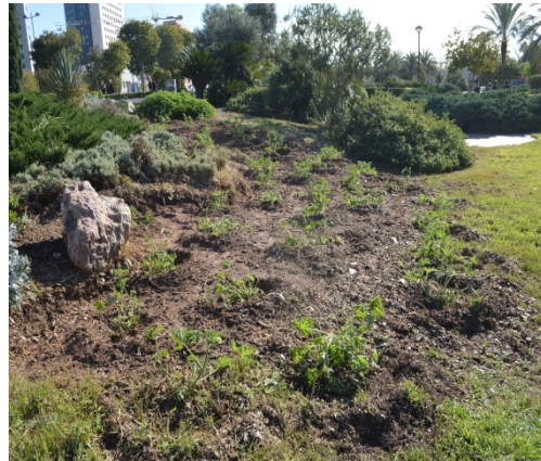
Replantación de taludes con pocetas para aprovechamiento de agua de lluvia.
