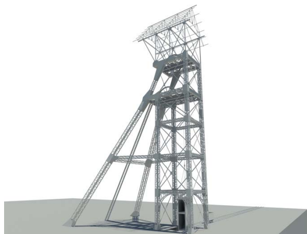
Figura 4: Castillete sobre el brocal del pozo de Herrera.
