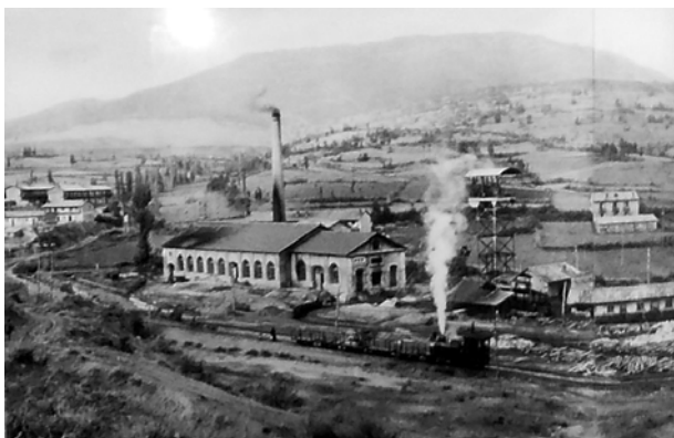
Figura 6: El Pozo de Herrera en los años 30. Años después el castillete fue reemplazado por el actual y la nueva sala de máquinas. La fotografía pertenece al fondo del Museo de la Siderurgia de Sabero.
