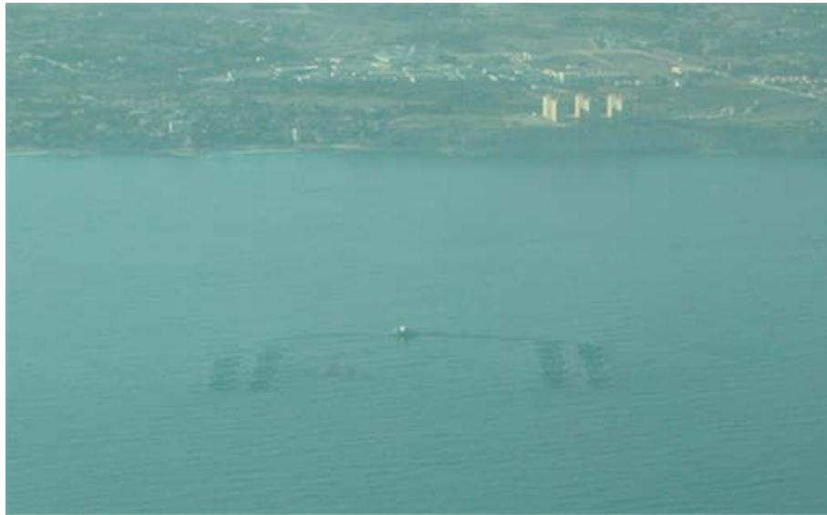
Figura 13. Vista aérea de la instalación.
