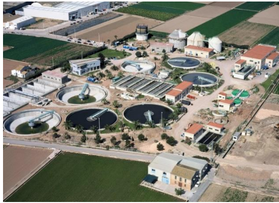
Figura 8. Planta depuradora del Carraixet (Alboraya).
