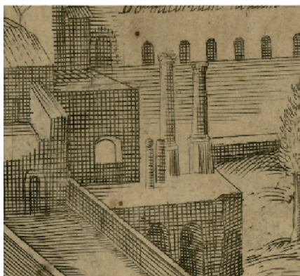
2-4a. Columnas dóricas listas para ser utilizadas en la construcción del nuevo vestíbulo
