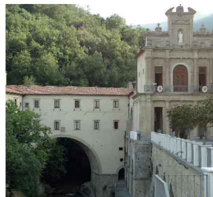
2-1b. En el siglo XVII el viejo puente de acceso al convento se convierte en la base para la construcción de la nueva enfermería
