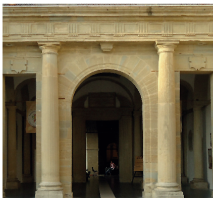
2-4b. Columnas dóricas del nuevo vestíbulo
