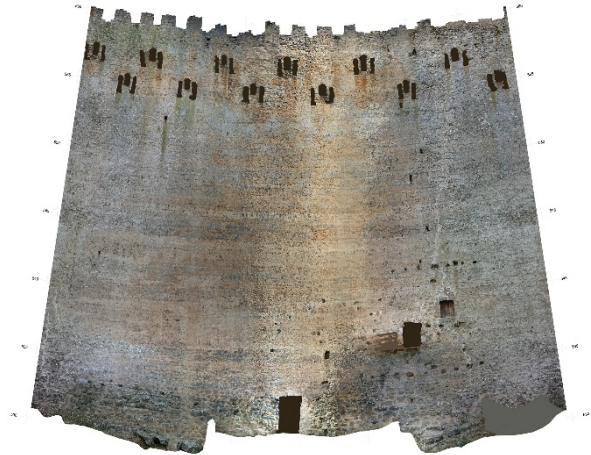
Figura 3: Desplegado ortofotográfico de la superficie exterior de la torre. GLOBAL GEOMÁTICA
