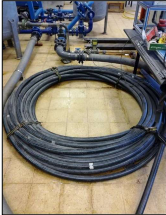
Fotografia IV Conducció de PEAD
