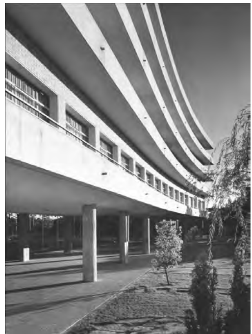
13. Planta sobre exenta sobre pilares de hormigón. Permeabilidad de las zonas deportivas. Archivo familiar de Luis Blanco-Soler
