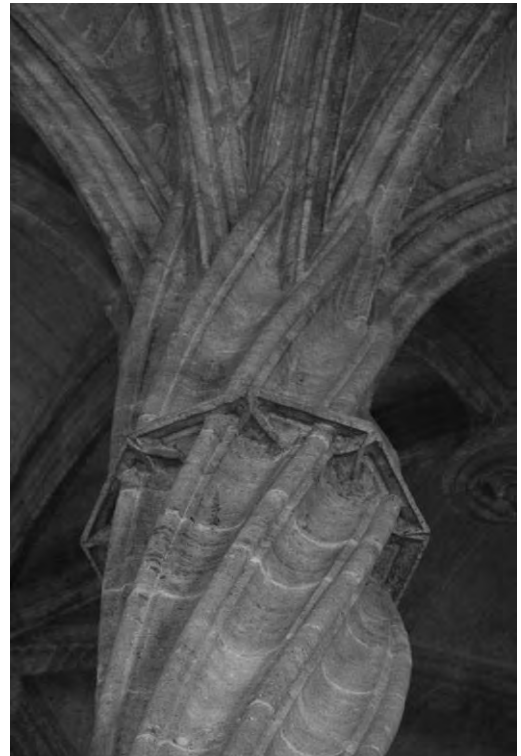
10. Encuentro entre columna y bóveda de la Sala de Contratación.
