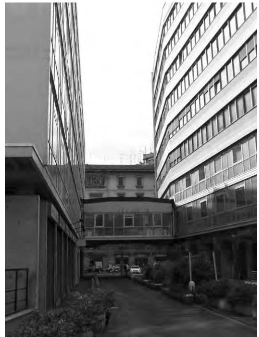
12. Complejo Corso Italia. Vista del pórtico de acceso desde el final de la calle interior. Nótese el cambio de alineación del bloque de la derecha (Foto: J.F. Picó).
