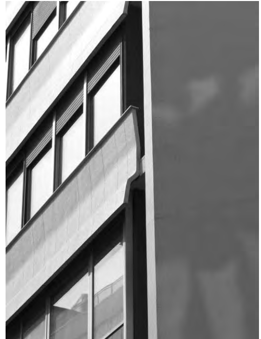
14. Complejo Corso Italia. Detalle del final del antepecho de las ventanas corridas del bloque “volante” (Foto: J.F. Picó).
