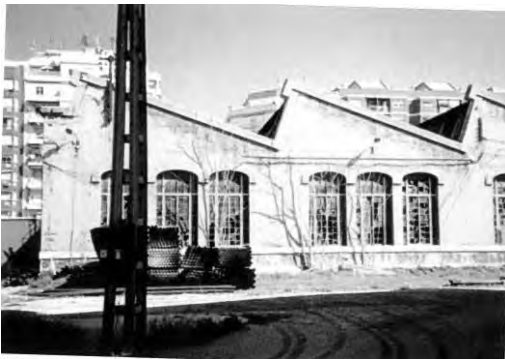
15. Talleres de Rodaje (Nave Shed), Estación del Norte, Valencia.
