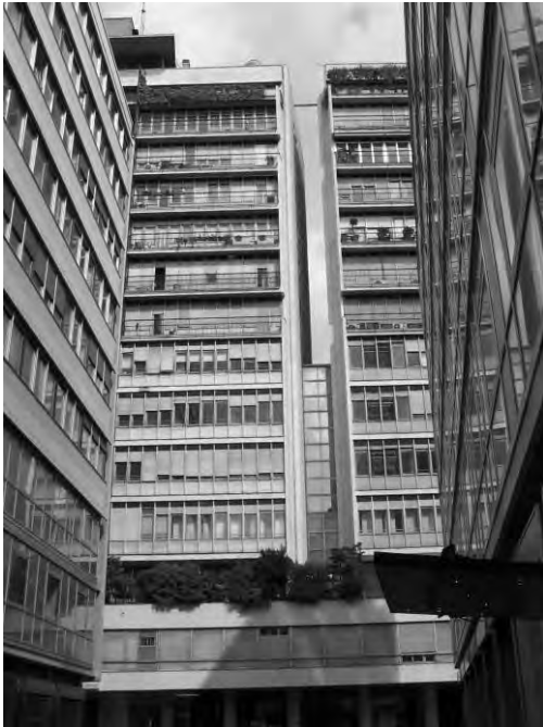
13. Complejo Corso Italia. Vista del bloque del fondo de la calle interior y de la rasgadura vertical (Foto: J.F. Picó).
