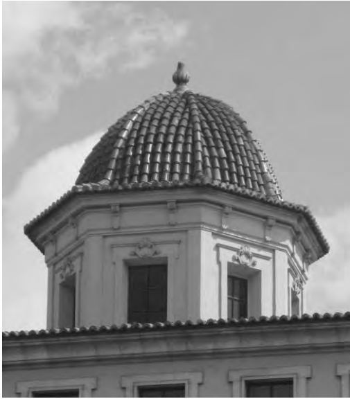
6. Cúpula de la escalera principal del Colegio de San Pablo (exterior).
