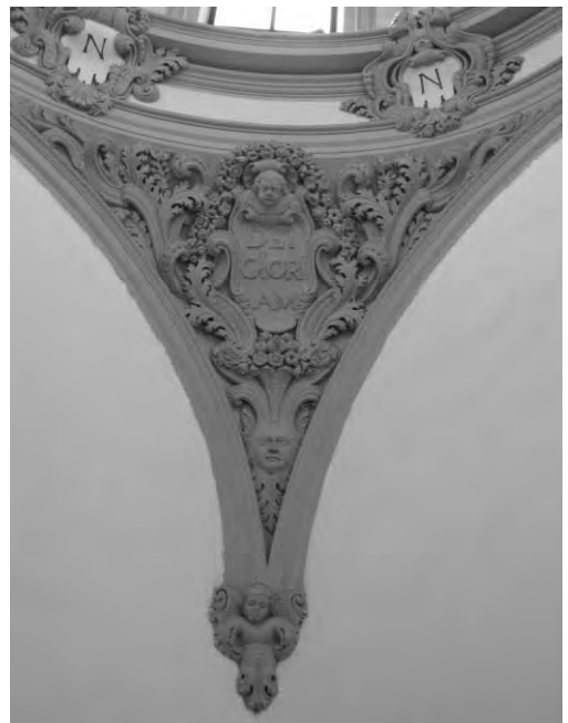
5. Cúpula de la escalera principal del Colegio de San Pablo (detalle).
