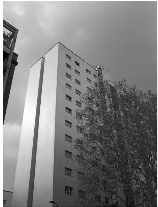
7. Casa Albergó vía Corridoni. Detalle del testero del bloque grande con las grandes superficies revestidas de piezas pequeñas de mosaico vidriado (Foto: J.F. Picó).
