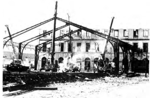
10. Montaje de la cubierta-marquesina de la Estación de Aragón, Valencia, 1902.
