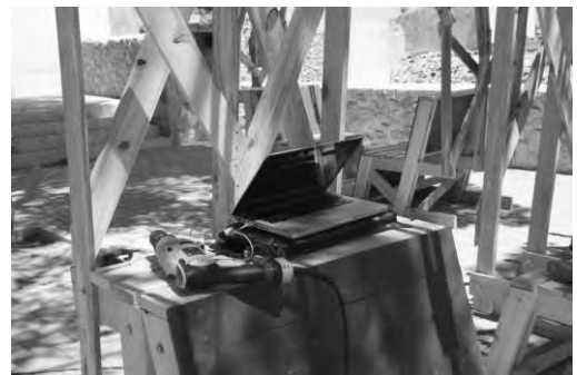
4. Instalación de cuevas urbanas. EICASC. Agosto 2013.
