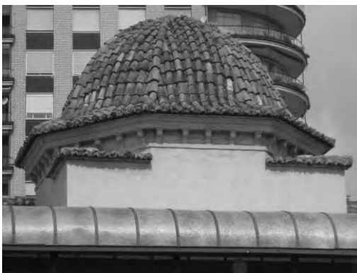
3. Cúpula de la escalera de la portería del Colegio de San Pablo (exterior).
