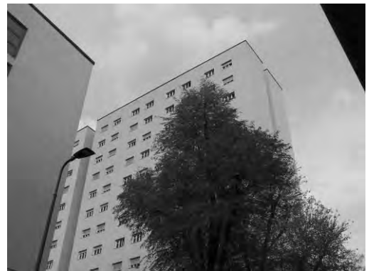
5. Casa Albergó vía Corridoni. Detalle de la fachada interior del bloque grande compuesta con huecos de ventanas iguales y con las superficies limitadas por las hendiduras verticales (Foto: J.F. Picó).
