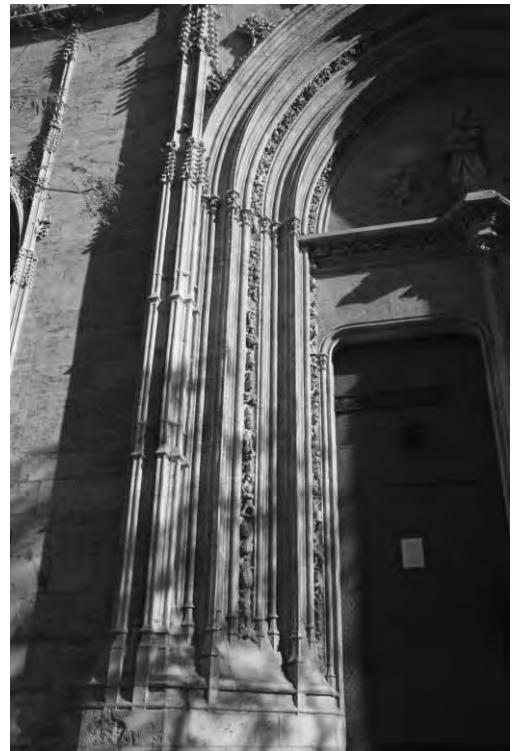
8. Perforación de hueco en el muro, realizada en diagonal, mostrando un haz de baquetones.
