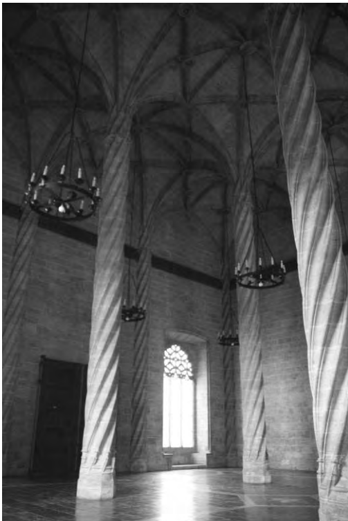
9. Columnas de la Sala de Contratación.
