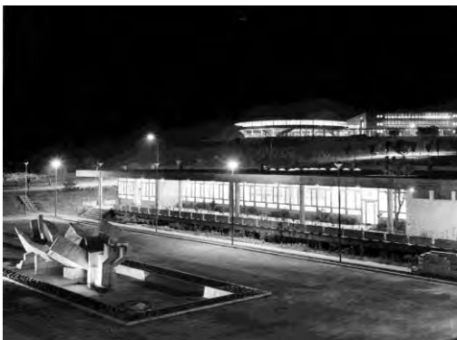
9. Universidad Laboral de Cheste: Plaza principal de acceso con escultura-fuente en hormigón armado diseñada por Javier Clavo © AP-CTAV.
