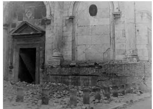
18. Estado de la fachada frontal tras la Segunda Guerra Mundial y antes de la restauración. Se aprecia la fábrica de ladrillo del zócalo como substrato del aplacado de mármol de acabado.
