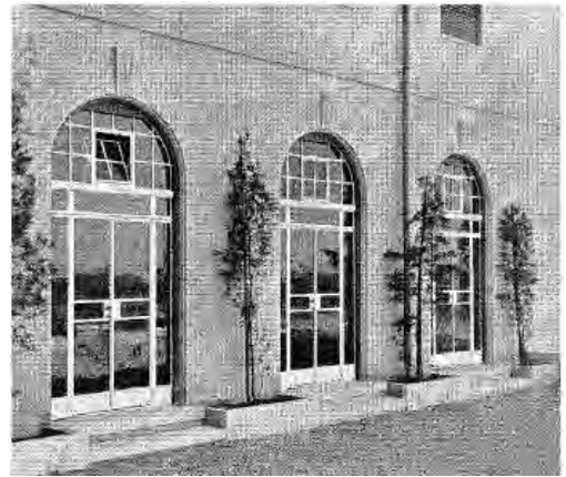
5. Residencia del Amo. Detalle exterior conexión con el jardín.
