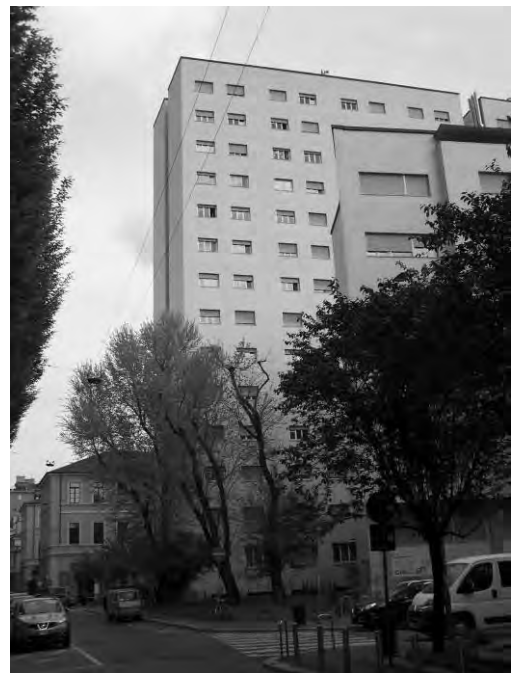
2. Casa Albergo vía Corridoni. Vista del conjunto desde la vía Corridoni (Foto: J.F. Picó).
