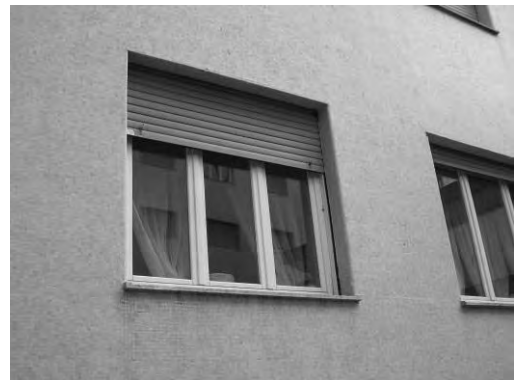
8. Casa Albergó vía Corridoni. Detalle de la solución constructiva del hueco de la ventana que se repite en todo el edificio (Foto: J.F. Picó).
