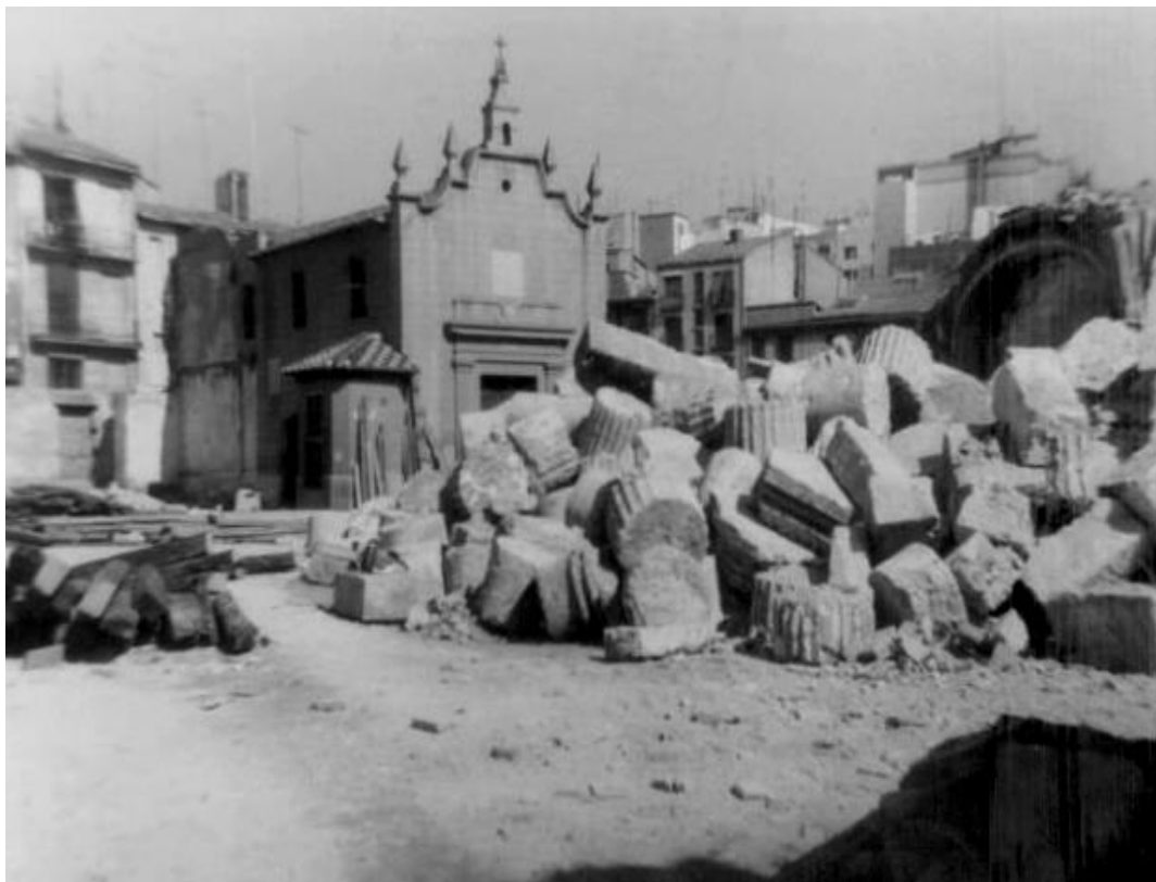
(Fig. 4) Restos de la demolición donde se observan parte de las columnas que luego colocarán en el futuro jardín. Valencia Historia Gráfica. Juan Soler < http://juanansoler.blogspot.com.es/2012/02/rincones-desaparecidos-de-valencia-1.html > [Consulta: 10 de abril 2017].
