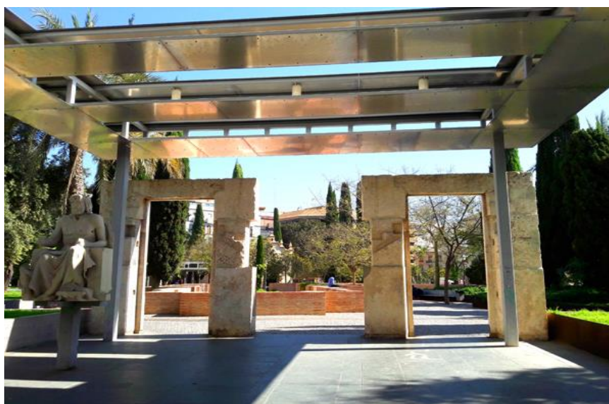
(Fig. 16) Acceso desde Guillem de Castro donde se pueden observar las pérgolas metálicas y la escultura de Esculapio a la izquierda. Elaboración propia.
