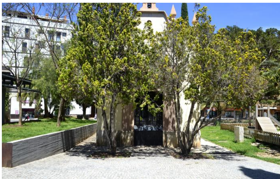
(Fig. 9) Estado actual de la Ermita del Capitulet.
