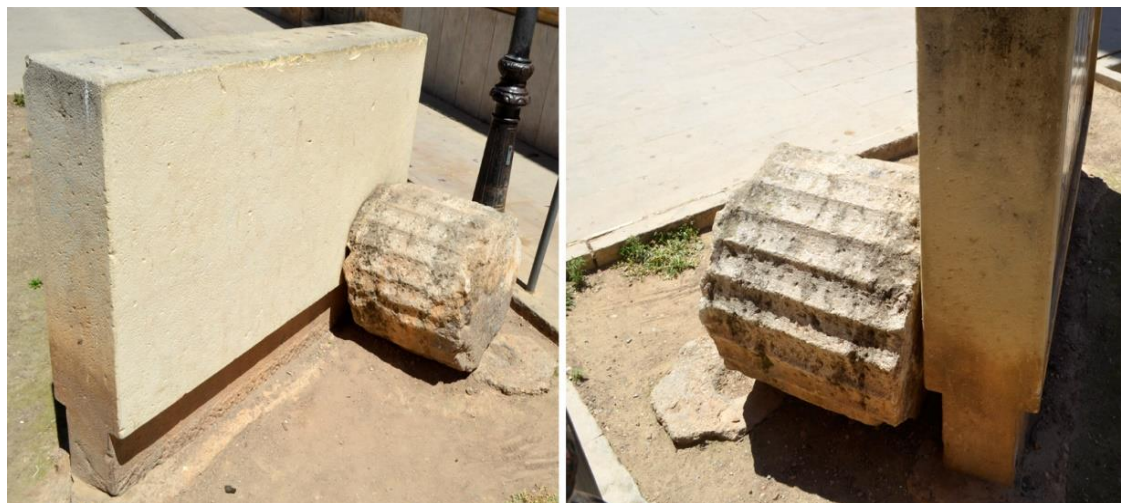
(Fig. 32) Parte de columna caída que apoya y sujeta la placa de entrada a la Biblioteca Pública desde la calle del Hospital. Elaboración propia.
