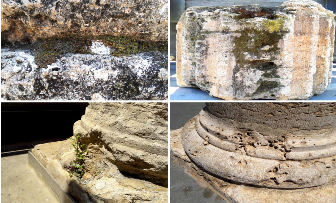
(Fig. 34) Deterioro en basas, capiteles y fustes de las columnas que forman parte del Parque Arqueológico.
