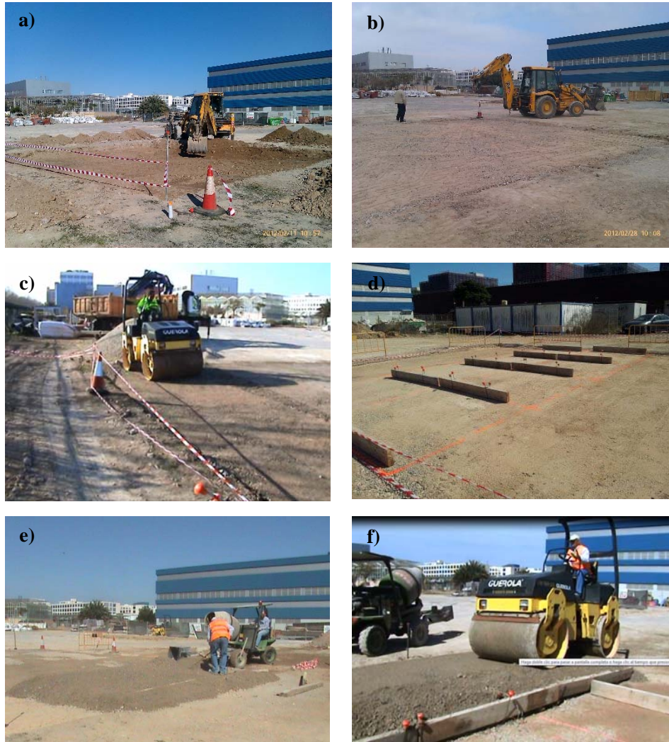
Figura 3.8. Proceso de construcción del tramo experimental. a) Fase de excavación del cimiento. b) Fase de extendido capa de forma. c) Compactación de la capa de forma. d) Replanteo de la secciones de la capa de subbalasto y mezclas. e) Extensión del material subbalasto en la Sección 1. f) Compactación de la Sección 1: Subbalasto Sub_Ref.
