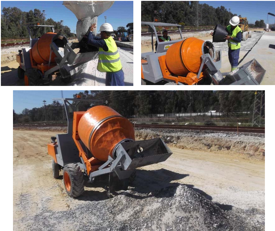
Figura 3.26. Fase de mezclado subbalasto-caucho en el tramo experimental.
