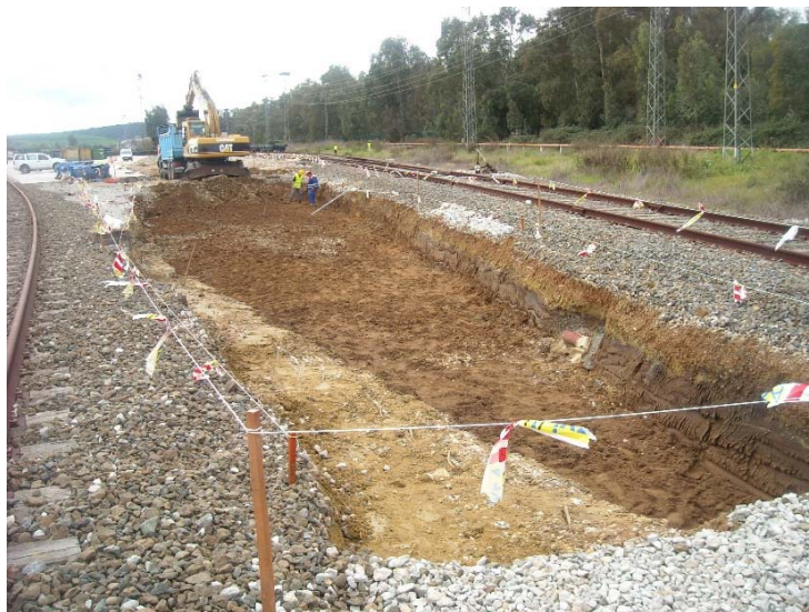
Figura 3.24. Preparación del cimiento de la plataforma ferroviaria del tramo de pruebas.
