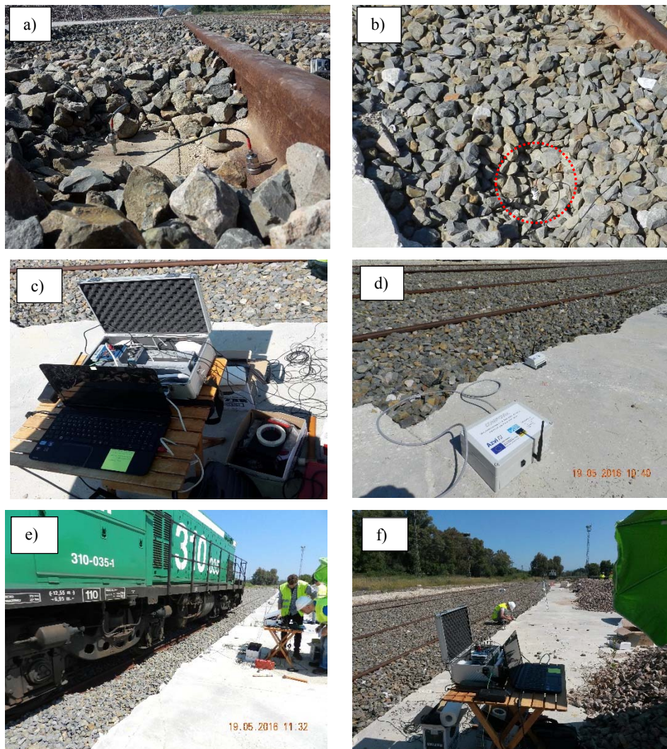
Figura 3.34. a) Ubicación Acelerómetros S0 (Carril) y S1 (Traviesa); b) Ubicación Sensor S2 (Balasto); c) Datalogger UPV; d) Datalogger US; e) Detalle locomotora; f) Vista general del tramo experimental durante la realización de la auscultación.
