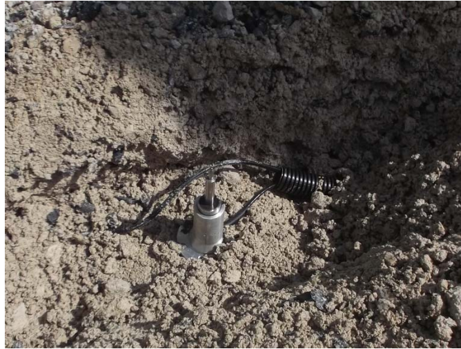
Figura 3.30. Colocación del Sensor LVDT en el interior del accesorio de posicionamiento vertical en la capa de subbalasto.
