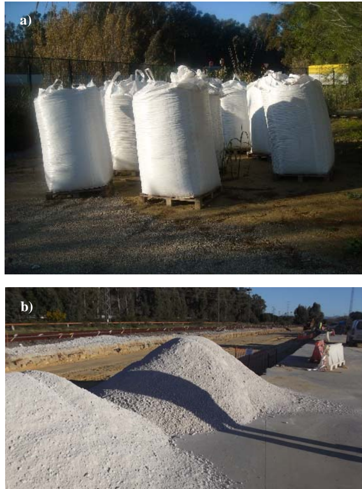
Figura 3.25. Acopios de los materiales en tramo el tramo experimental. a) Big bags de partículas de caucho (NFU's). b) Acopio de subbalasto.
