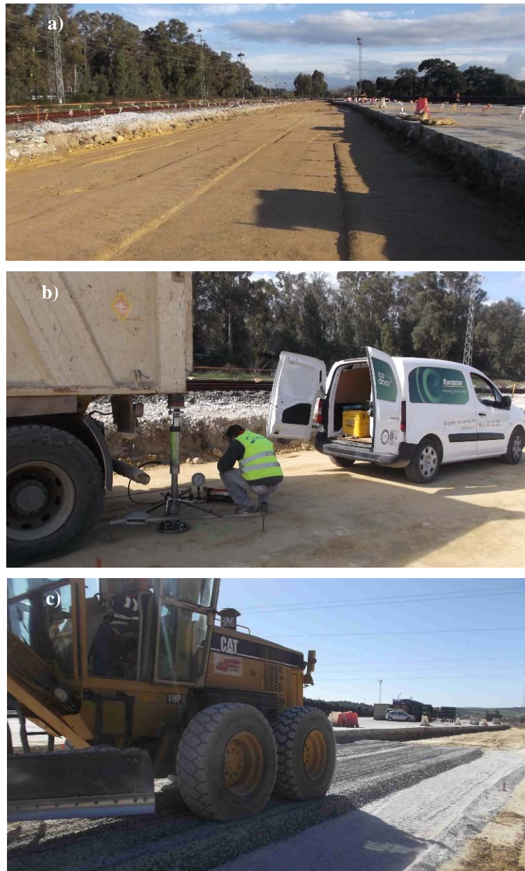
Figura 3.27. a) Capa de forma, en proceso de compactación. b) Ensayo de Placa de Carga en la capa de forma. c) Fase de extendido de la capa de subbalasto, mezcla de árido-caucho con motoniveladora.
