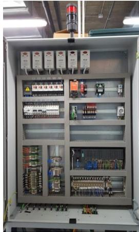
Figura 5.6. Cuadro eléctrico de potencia y control.
