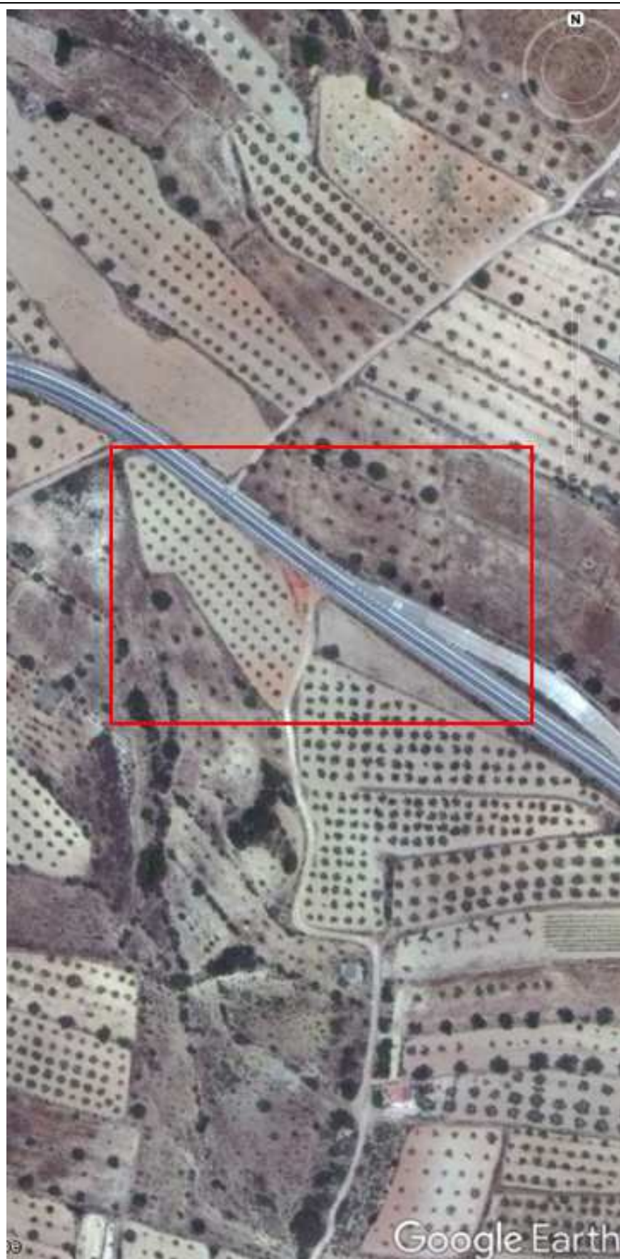
Figura 73. Curva de radio 1081 m de la CV-345.
