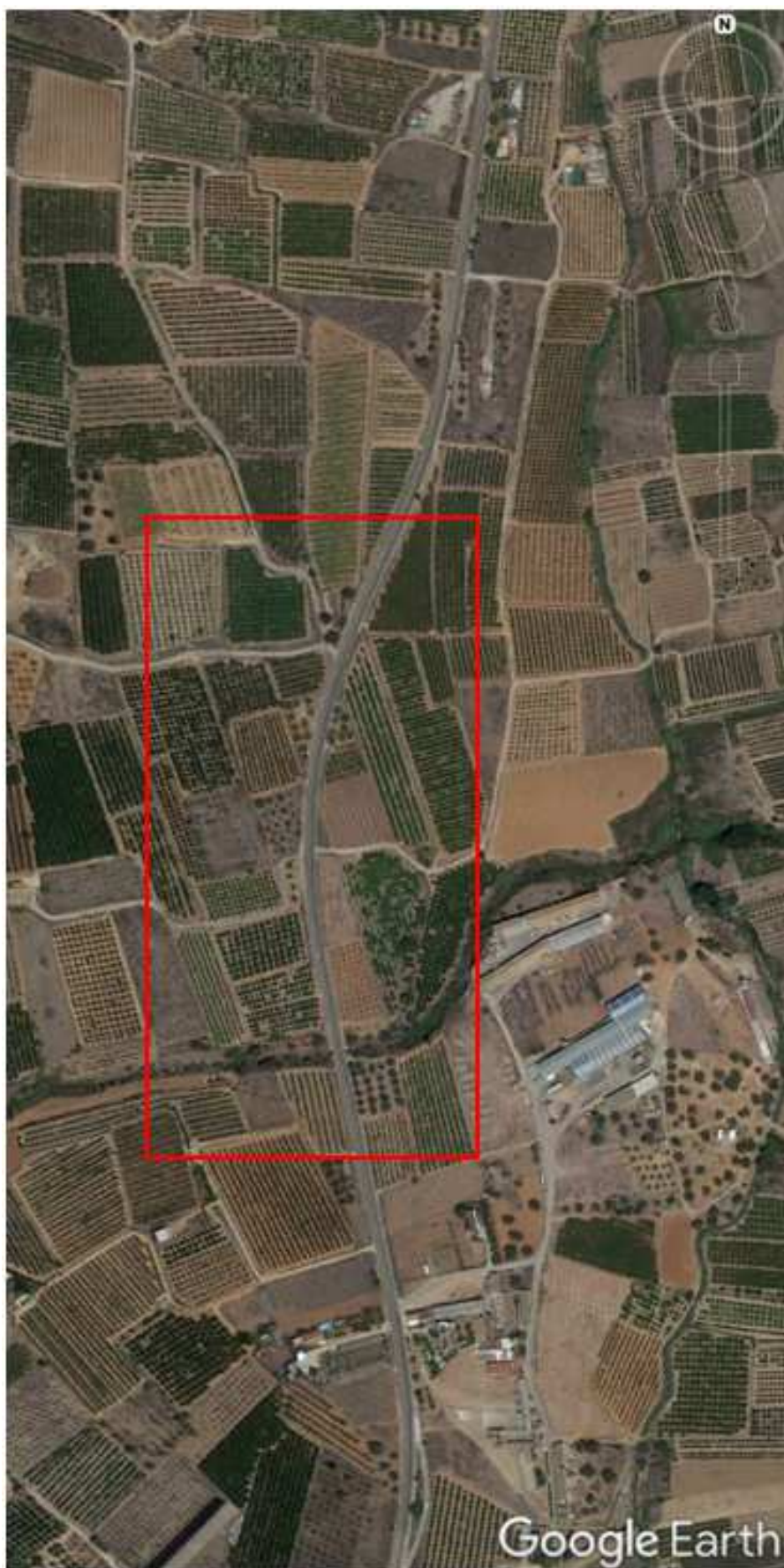
Figura 68. Curva de radio 457 m de la CV-50.
