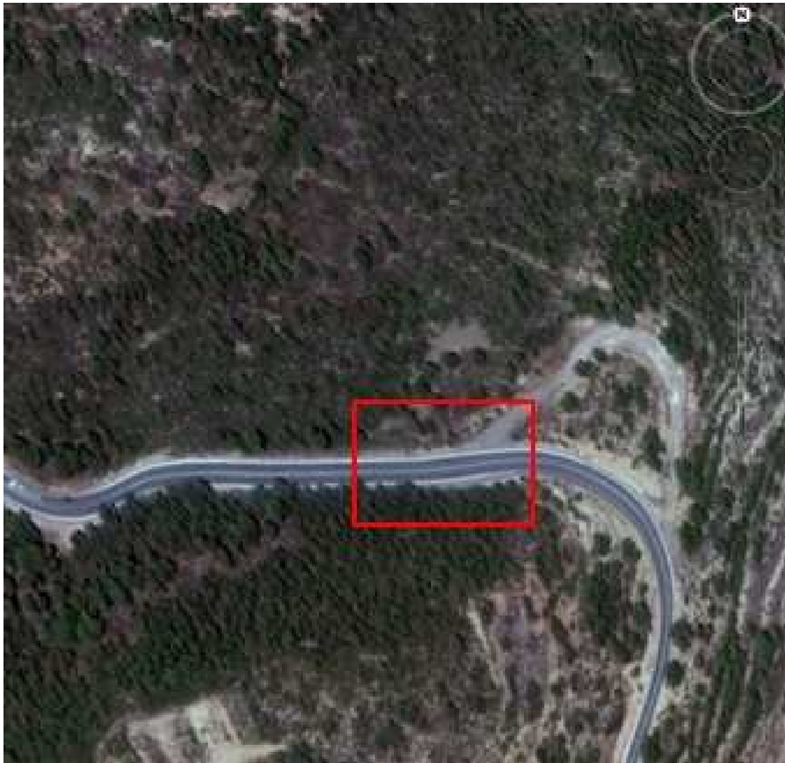
Figura 78. Curva de radio 763 m de la CV-345.
