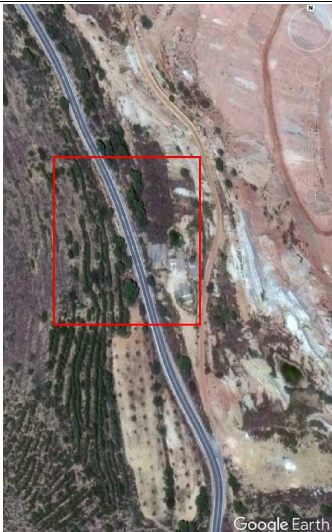
Figura 76. Curva de radio 983 m de la CV-345.
