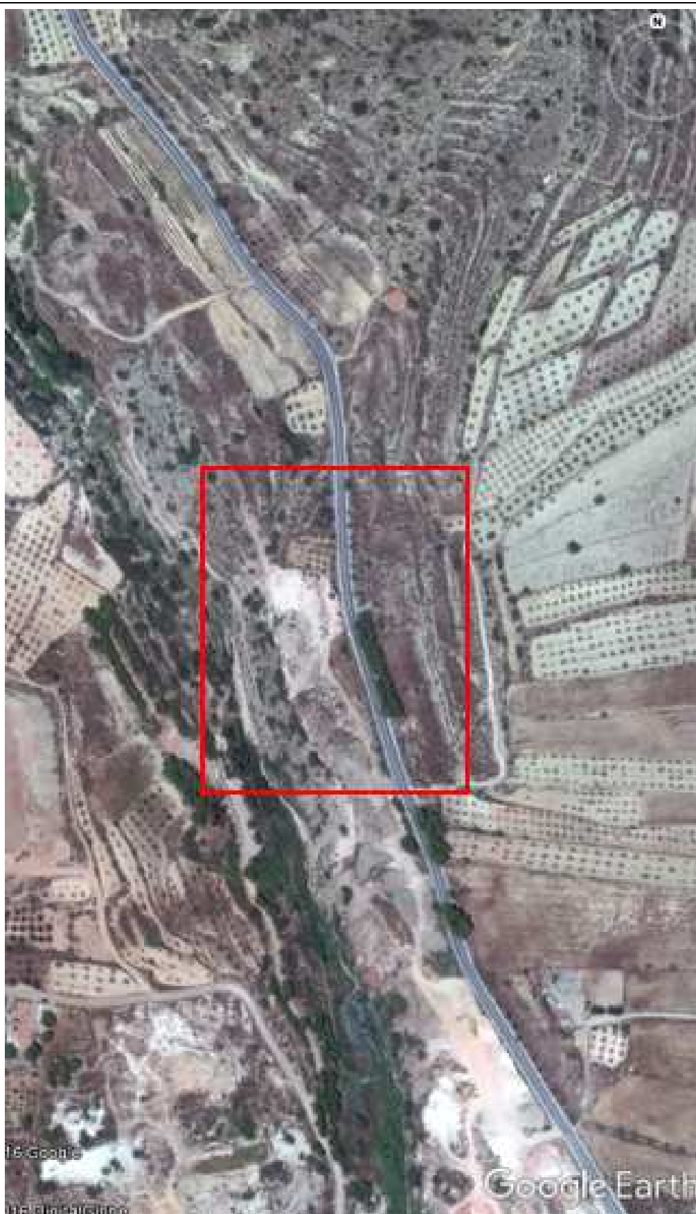
Figura 77. Curva de radio 1244 m de la CV-345.
