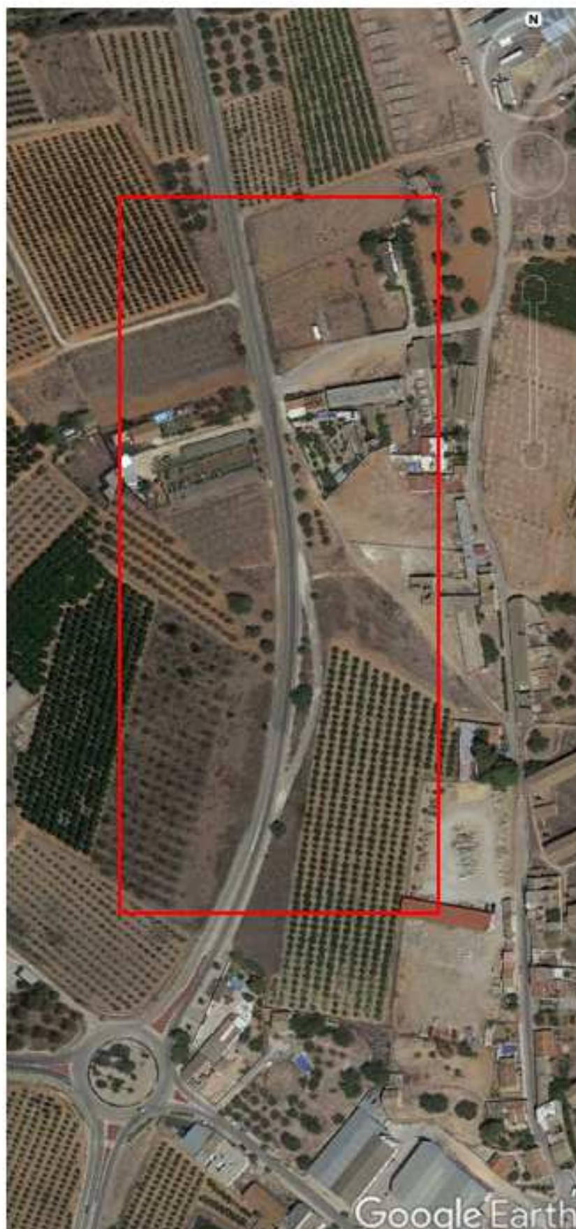
Figura 67. Curva de radio 459 m de la CV-50.
