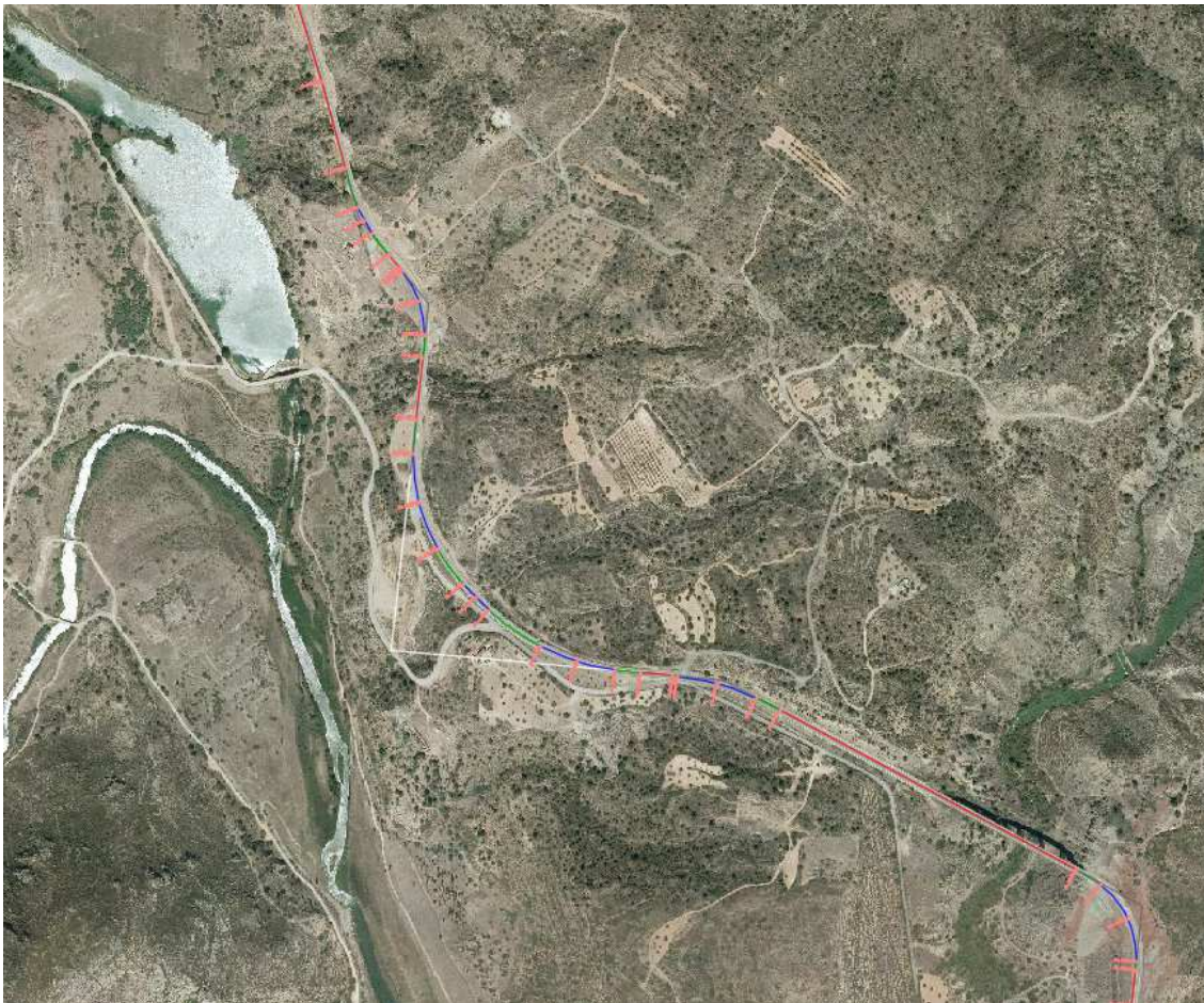
Figura 105. Restitución del trazado horizontal de la carretera CV-35 entre Tuéjar y Titaguas
