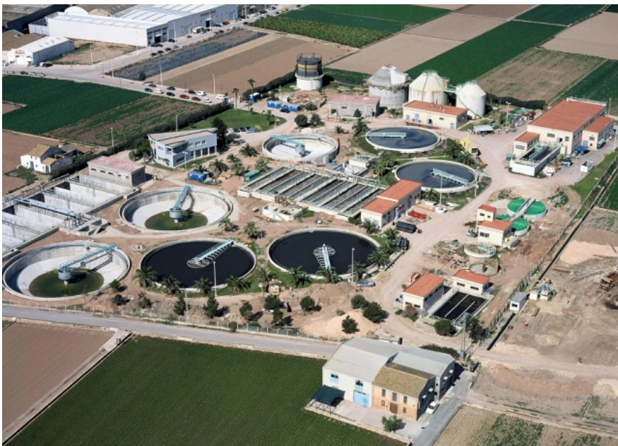
Figura I-12. Vista aérea de una Estación Depuradora de Aguas Residuales urbanas. Fuente: EPSAR (Generalitat Valenciana).
