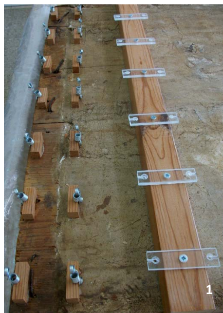
1.- Detalle del sistema de travesaños móviles nuevos 2.- Detalle del rebaje en los travesaños nuevos para conservar los clavos de forja originales 3.- Detalle del resultado final
