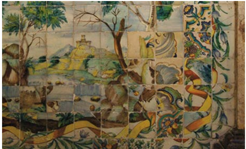
Estado de conservación inicial de un panel con gran cantidad de piezas recolocadas de forma errónea e inadecuada
