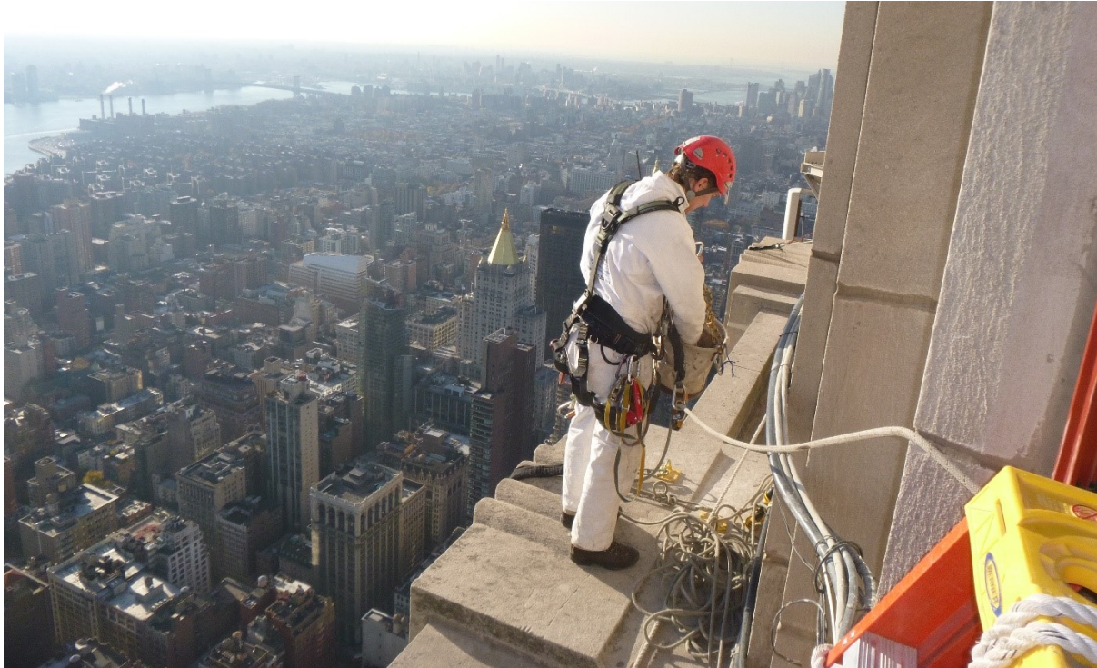
Figura 2.6-17 El inspector de la imagen se dispone a utilizar un sistema industrial de acceso mediante cuerdas para acceder a las ventanas de la planta 84 a la 86 del Empire State Building, para evaluar el estado del encuentro de las mismas con la fachadas, mediante la técnica de END de termografía. Todo lo que el técnico necesita es el arnés, dos cuerdas (y sus respectivos anclajes), ascensor y descensor.
