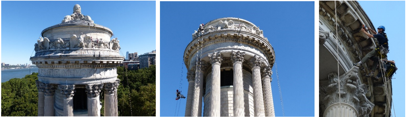
Figura 3.5-5 La fotografía de la derecha muestra el sistema industrial de cuerdas instalado para tres personas. La imagen central muestra dos de los arquitectos del equipo de LERA/VA durante el proceso de inspección. La fotografía de la derecha corresponde al equipo de ingenieros de GBG durante parte de la evaluación no destructiva.
