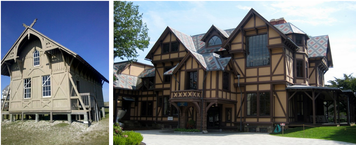
Figura 1.4-7 Estilo Stick. A la izquierda, Chicamacomico Life-Saving Station, de 1874, situada en Rodanthe, NC (Elisabeth Burlington) . A la derecha, la residencia de John N. Grisworld en Newport, Rhode Island, construida en 1862 por Richard Morris Hunt (Studyblue).
