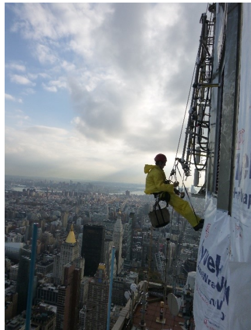
Figura 2.4-21 Vigilancia del test de estanqueidad desde el exterior mientras otro técnico observa desde el interior con una termocámara (K. Dalton).
