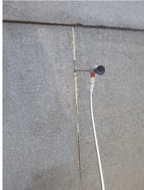
Figura 3.4-2 Boroscopio rígido introducido por uno de los faltantes de junta.
