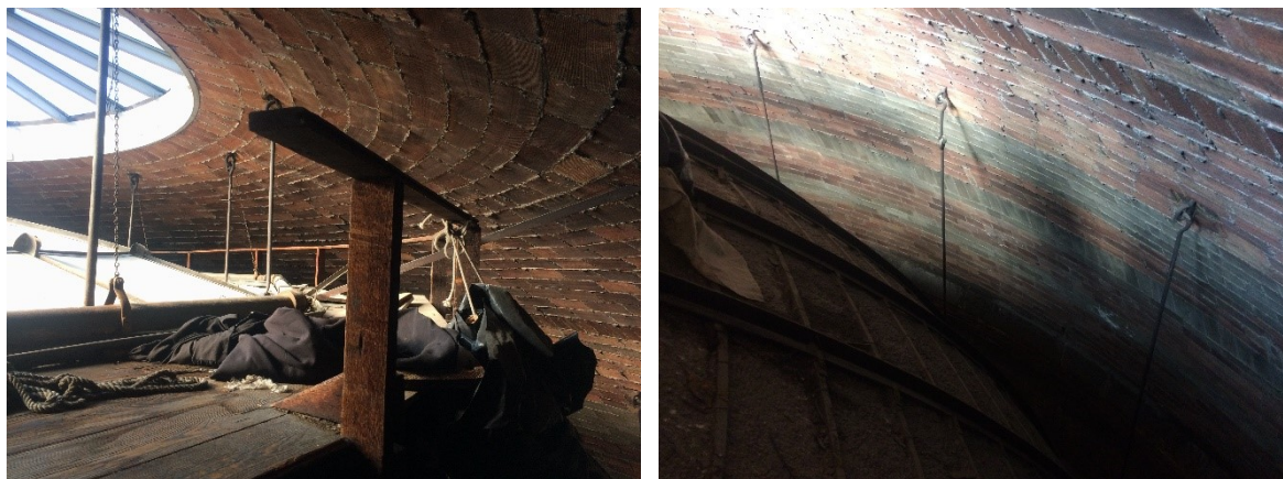
Figura 3.3-8 La fotografía de la izquierda muestra el nivel superior de tirantes de conexión de acero (conectan la cúpula superior de ladrillo con la cúpula inferior de yeso). La fotografía de la derecha muestra el nivel inferior de conectores.
