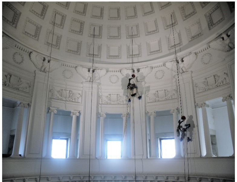
Figura 3.2-6 En la imagen, el técnico de la izquierda está realizando un test con boroscopia mientras que la de la derecha realiza una inspección visual documentada con TPAS.
