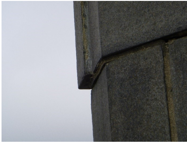
Figura 3.4-8 Fotografías que muestran desplazamientos del aplacado de granito.
