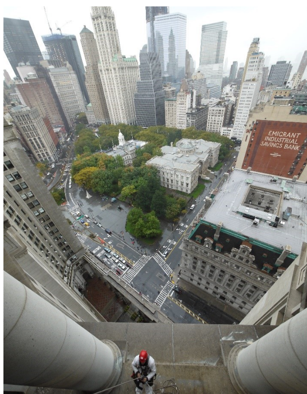
Figura 2.6-12 En Estados Unidos, especialmente en ciudades como Chicago o Nueva York, gran parte del patrimonio construido corresponde a edificios de más de quince plantas. El acceso por medio de cuerdas facilita las inspecciones habituales de fachadas y la aplicación de END. La fotografía se tomó durante la inspección del Municipal Building en Manhattan, de McKim, Mead & White inaugurado en 1914 con 176 m de altura. Al fondo se observa en Woolworth Building, el edificio más alto del mundo desde 1913 a 1930, y otros de gran altura construidos en la misma época (K. Diebolt).
