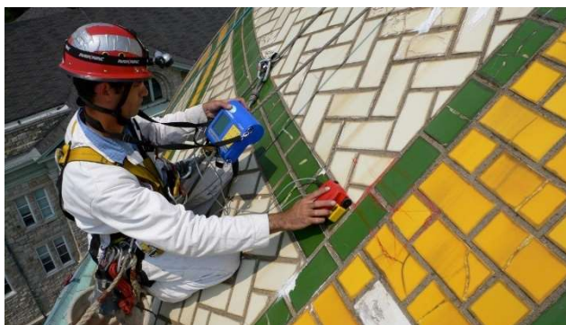
Figura 4.1-1 Proceso de inspección de la cúpula tabicada de Guastavino en la iglesia de St. Francis de Sales, Philadelphia (PA), por la empresa Vertical Access (V.A.LLC).
