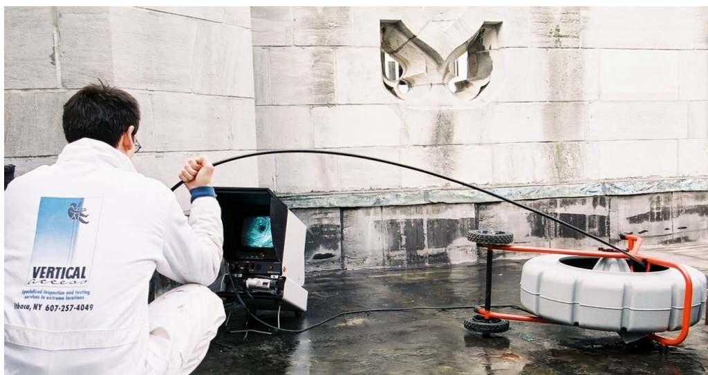
Figura 2.3-8 Cámara de tubería Seesnake, investigando una bajante en la cathedral de Saint Patrick en Nueva York (Vertical Access)
