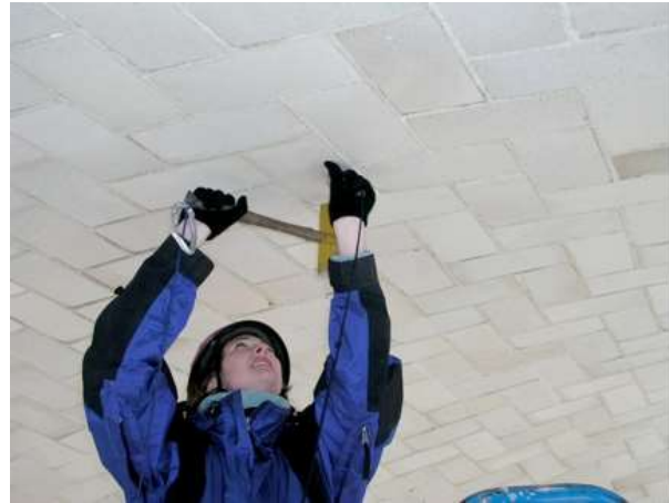
Figura 4.1-2 La ingeniera Kelly Streeter evaluando la bóveda de Guastavino de 1921 del Plymouth Rock Portico (de los arquitectos McKim, Mead and White), en Massachusetts (V.A. LLC)
