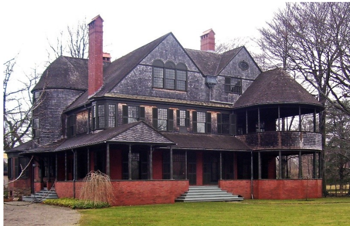
Figura 1.4-8 Estilo Shingle, fruto de la evolución en la costa este del estilo Queen Anne de la costa oeste. La residencia de Isaac Bell House, diseñada por la firma de arquitectos McKim, Mead and White y construida en 1883 en Newport, RI. En aquella época, Newport era el lugar de veraneo de las familias más ricas del país (Daniel Case).
