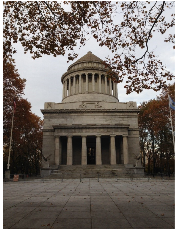
Figura 3.2-1 Vista general exterior del monumento
