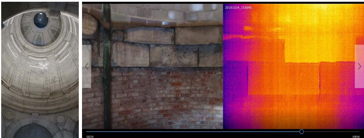
Figura 2.6-7 El UAV de la imagen, un Phantom 3, equipado con cámara térmica FLIR, fue utilizado en noviembre de 2016, para evaluar el estado de una cúpula de Guastavino situada en la posición más alta del monumento Soldiers and Sailors en Manhattan. A la derecha pueden observarse, una captura del video digital y otra captura del video termográfico del encuentro de dicha cúpula con su base. Ambas imágenes delatan la presencia de filtraciones.
