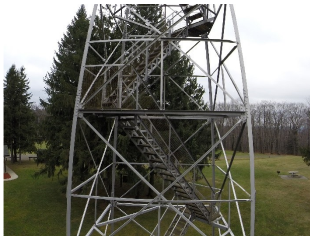
Figura 2.3-29 Fotografía tomada desde un UAV con una cámara GoPro para generar el modelo de la Figura 2.3-27 en la que puede apreciarse la deformación de la imagen debido al gran angular de este tipo de cámaras.
