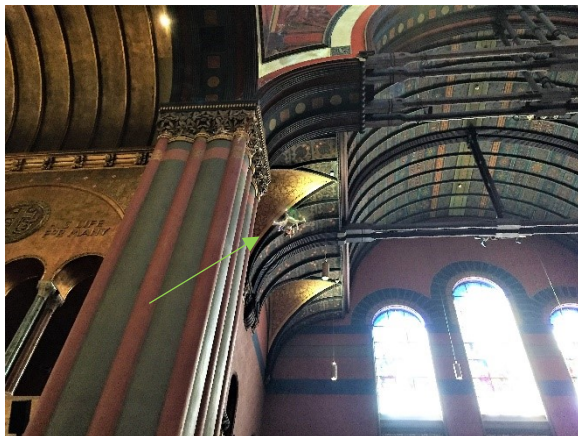
Figura 2.6-9 Vuelo de un UAV DJI Phantom 3 con protección de hélices en el interior de la iglesia Trinity en Boston. A la derecha puede observarse la pantalla a la visión en tiempo real de la cámara GoPro instalada en el UAV. La imagen delata una patología de decoloración de la pintura mural, muy probablemente fruto de humedades intersticiales en esa zona. Dicha patología no puede ser observada desde el suelo de la nave (K. Diebolt).
