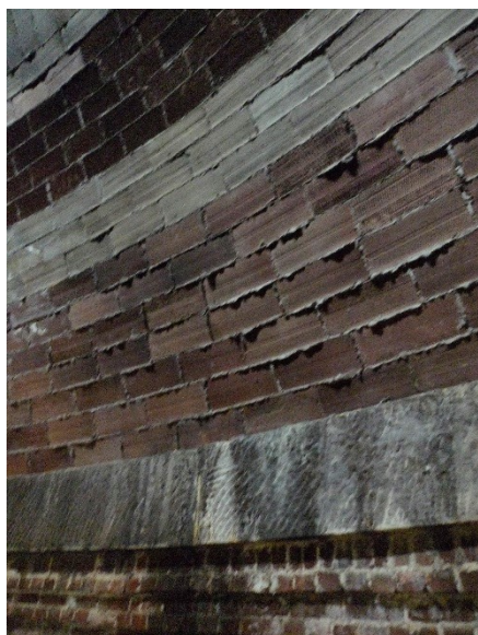
Figura 3.3-5 Encuentro en la base de la cúpula entre el ladrillo y la piedra sobre la que se asienta.
