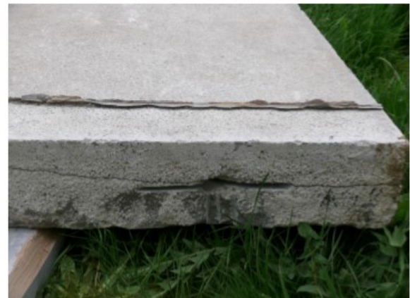
Figura 3.1-3 Delaminación tipo en una de las piezas utilizadas para la calibración del equipo.
