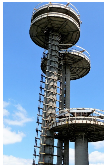
Figura 1.4-38 Un ejemplo significativo son las torres del pabellón del estado de Nueva York en la exposición internacional en Flushing Meadows-Corona Park en Queens, Nueva York. Construidas en 1964 fueron diseñadas por Philip Johnson para ser un edificio temporal que sería desmantelado tras la exposición, lo cual nunca ocurrió. En pésimo estado de conservación en la actualidad, sería sustancialmente más económico demolerlas que restaurarlas. Sin embargo, ante los motivos expuestos en The Secretary of the Interior's Standards and Guidelines for Archaeology and Historic Preservation, se están buscando alternativas a su demolición.
