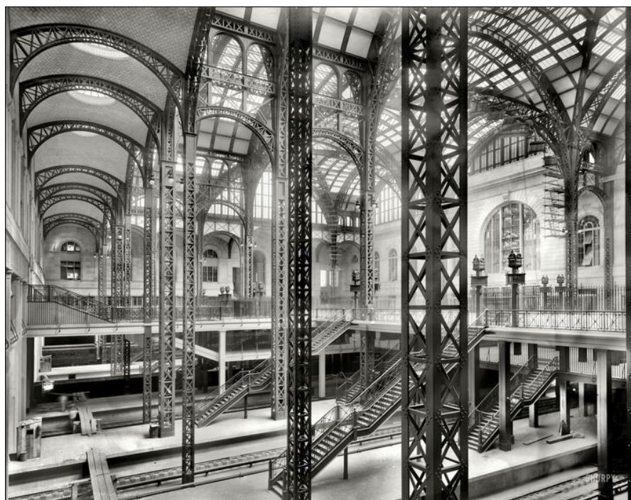
Figura 1.4-39 Interior de Pennsylvania Station de Nueva York en 1962. La estación, diseñada en estilo Beaux-Arts por McKim, Mead and White, se inauguró en 1910. Pese a la larga lucha social, la estación fue demolida en 1965. Esta pérdida fue uno de los puntos de inflexión que desencadenó el marco legal necesario para salvaguardar el patrimonio estadounidense (National Park Service, 2016).
