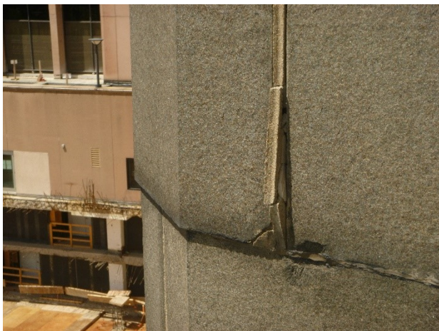
Figura 3.4-10 La imagen de la izquierda muestra desprendimiento del mortero de cemento de las juntas, mientras que la imagen de la derecha muestra la existencia de dos materiales diferentes en la junta. También puede observarse el acceso por el método no invasivo IRA.
