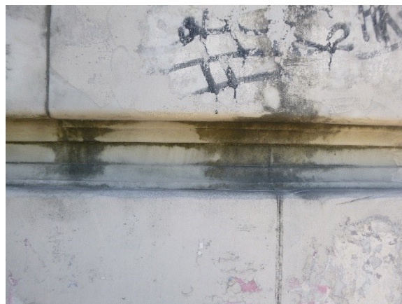
Figura 2.3-38 Esta fotografía corresponde a uno de los asteriscos azules de la Figura 2.3-37; el nombre que recibe automáticamente en el momento de su captura es: 266-17 Stone_SoilStain Atmospheric-1, que corresponde a las coordenadas x e y, la condición, y el número de archivo y la lesión.
