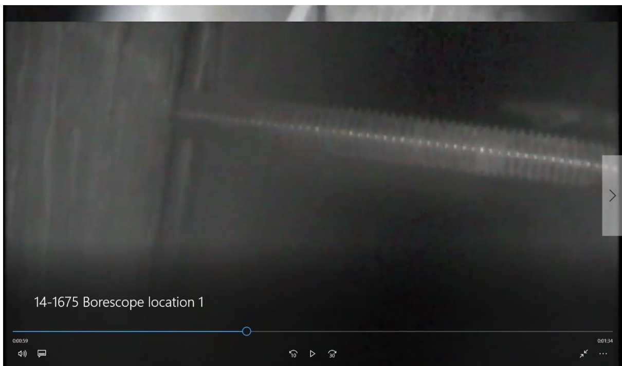
Figura 3.4-6 Fotografía de una de las secuencias del video registrado con el boroscopio. La imagen muestra uno de los anclajes laterales y su buen estado de conservación.
