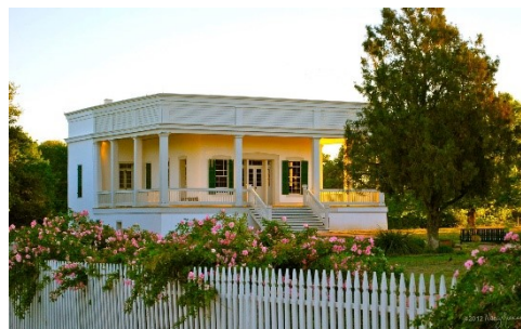
Figura 1.4-23 La Sebastopol House en Seguin, Texas es, construida en 1856 en estilo neoclásico-griego es uno de los primeros ejemplos de hormigón de cal (limecrete). (Seguin Texas Government, 2016)
