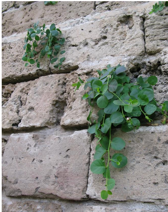
Fotografía 1.3.2. Alcaparras creciendo entre las grietas de las paredes de piedra.
