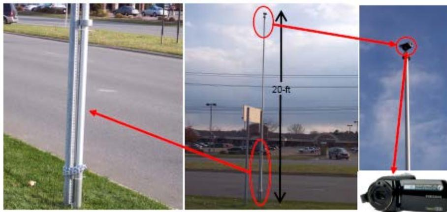
Figura 22. Instalación de cámaras, Savolainen et al. (2012).
