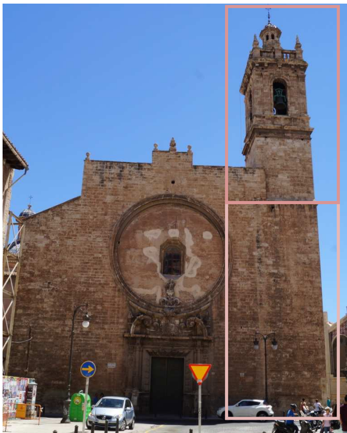
02.34. Vista de los Santos Juanes desde la plaza del cementerio de San Juan. Distinción de etapas constructivas del campanario. Autor (2015).
