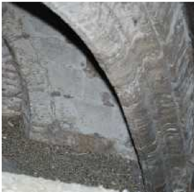
02.38. Detalle por el trasdós del encuentro entre la bóveda y el arco fajón medieval (2011) 68 .
