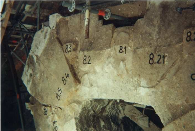
02.63. Proceso de numeración para el desmontaje de la torre del reloj (Piqueras Tejedor 1996).
