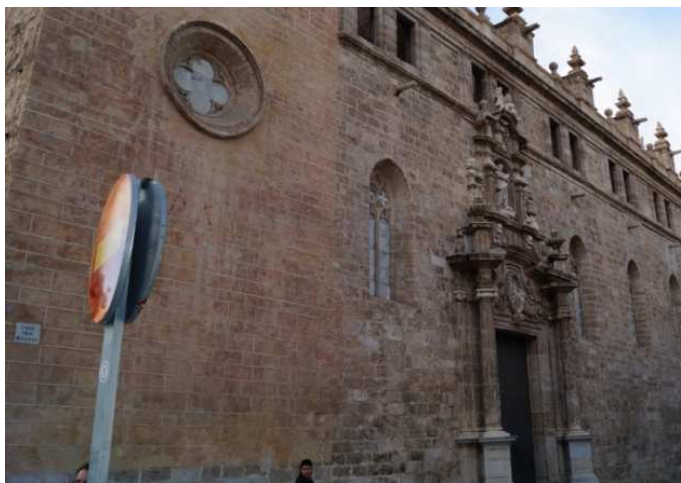
02.13 Acceso Lateral desde la Calle del Peso de la Paja. Autor (2015).
