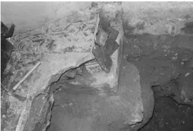
02.59. Cimentación de la Jamba Izq de la Puerta de la C/ el Peso de la Paja II (Estellés Ceba 1986).
