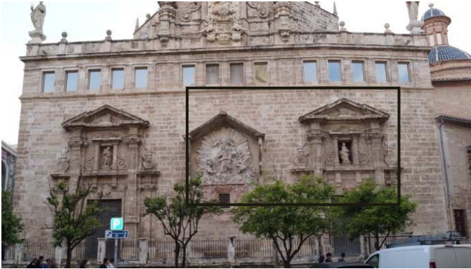
04.18. Imagen de la fachada de la plaza del Mercado. Autor (2015).
