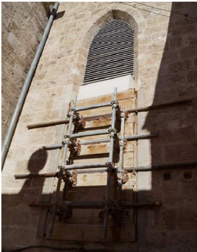
02.40. Detalle ventana sobre terraza de las capillas laterales en la calle Peso de la Paja. Autor (2015).
