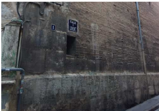
02.27. Vista de la fachada de la Capilla Comunción a la calle Eixarchs. Autor (2015).
