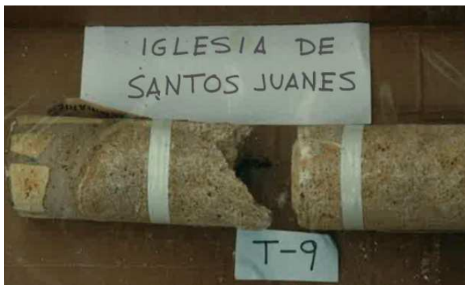
02.60. Detalle de un testigo realizados en los muros interiores (Estellés Ceba 1986).
