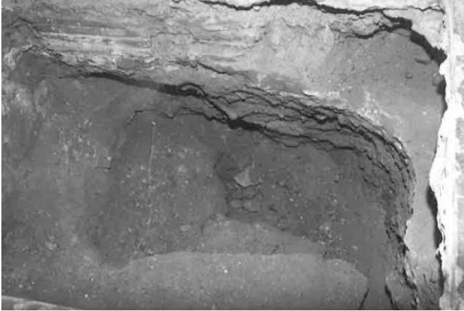
02.58. Cimentación de la Jamba Izq de la Puerta de la C/ el Peso de la Paja I (Estellés Ceba 1986).
