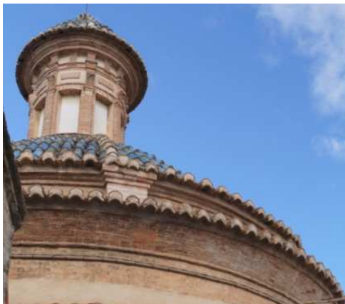
02.28. Detalle de la cúpula de la capilla de la Comunión. Autor (2015).
