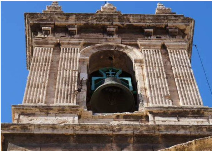
02.35. Detalle del campanario. Autor (2015).
