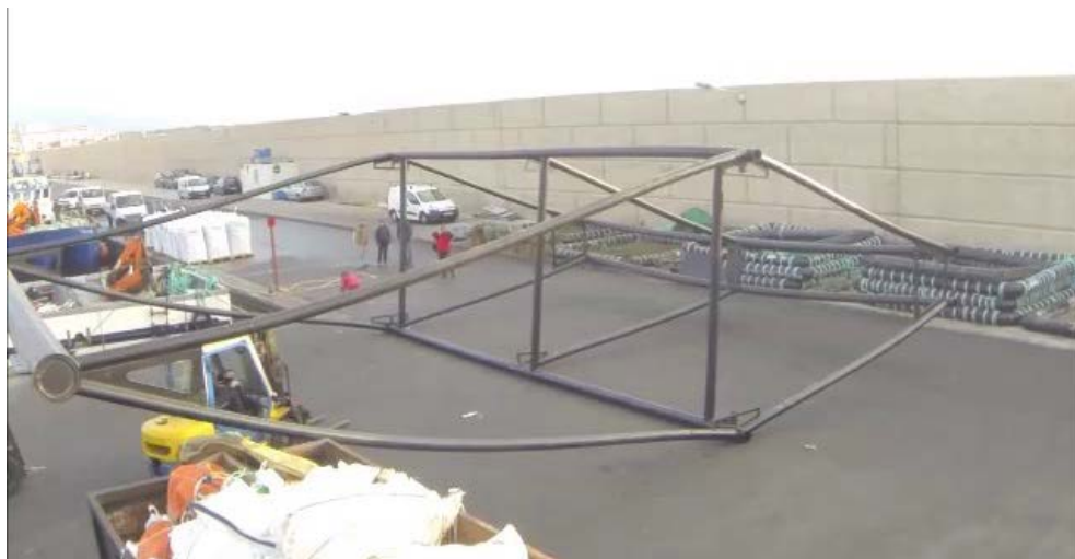
Figura 8.6. Imagen de la estructura en el puerto de l'Ametlla de Mar antes de ser llevada a las instalaciones en el mar el día 27-01-2016 .
