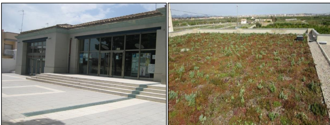
Figura 15 Aljibe de aprovechamiento de aguas de lluvia en el centro juvenil (izquierda). Cubierta Vegetada centro social (derecha). Fuente: Aquaval.
