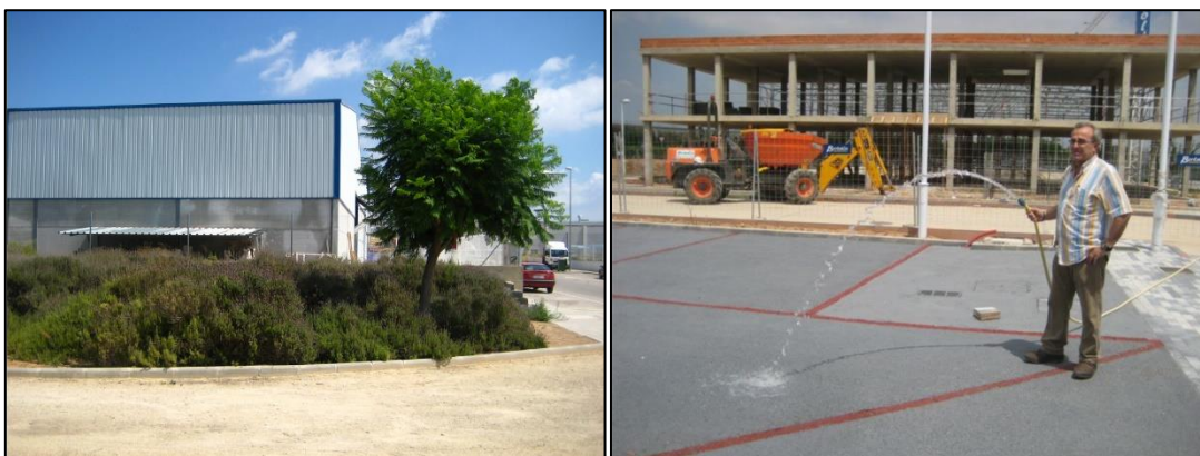
Figura 14 Balsa de infiltración polígono Las Eres, Benaguasil (izquierda). Pavimento permeable piscina cubierta Municipal (derecha). Fuente: Aquaval.
