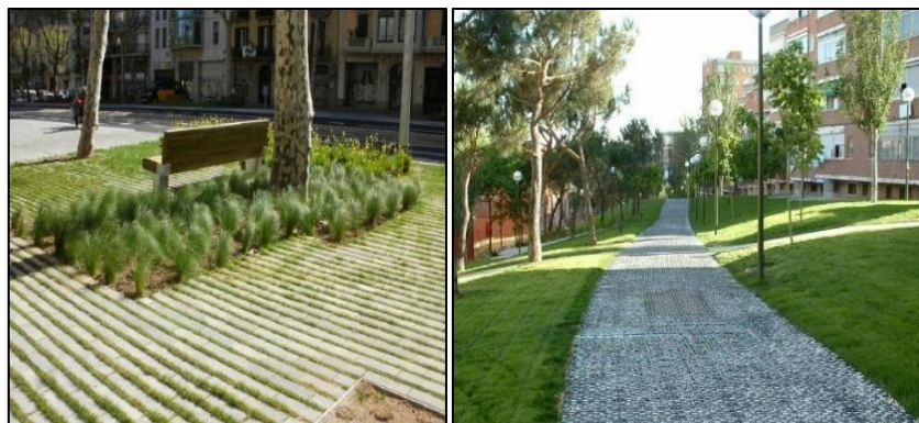
Figura 56 Pavimento Permeable. (Fuente: susdrain.org)
