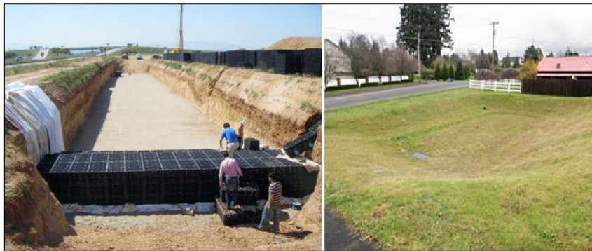
Figura 58 Depósito de infiltración. (Fuente: Construnario.com)
