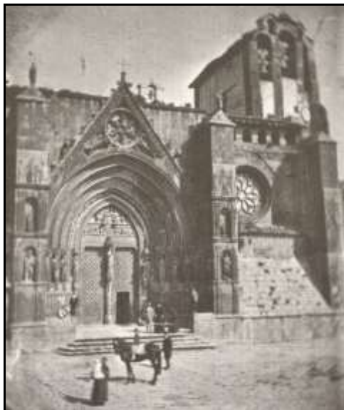
Fig. 2. Plaza, portal de los Apóstoles y campanario de la arciprestal. Vista antes de la reforma (por destrozo militar) llevada a cabo por el Gobernador Manuel Villacampa del Castillo en 1874-75. Fuente: Foto del archivo Luís Cruella (ca. 1870).
