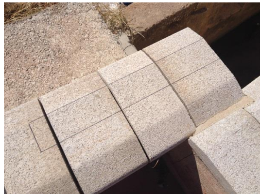
Figura 4.21. Marcado del punto de estacionamiento. Elaboración propia.
