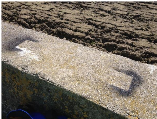
Figura 4.50. Marcado del punto de estacionamiento. Elaboración propia.
