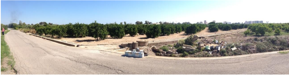
Figura 4.11. Vista panorámica del punto de estacionamiento VALE10K. Elaboración propia.
