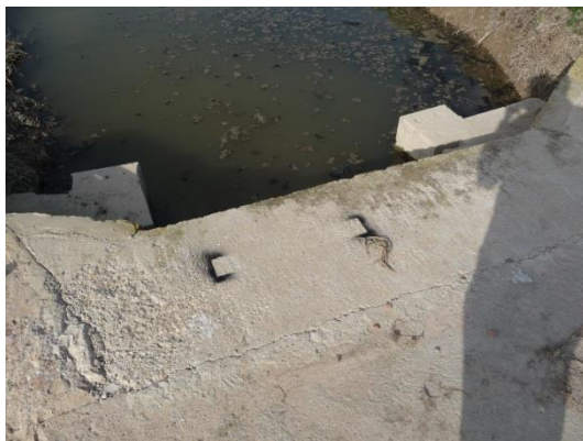
Figura 4.45. Marcado del punto de estacionamiento. Elaboración propia.
