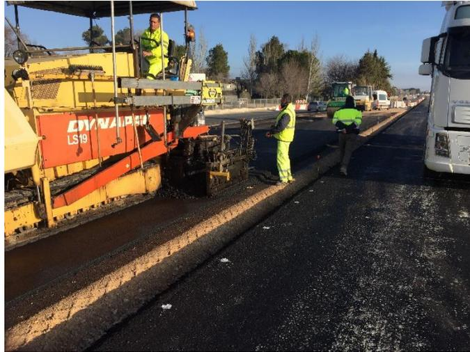
*Ilustración 41. Vertido del material*
