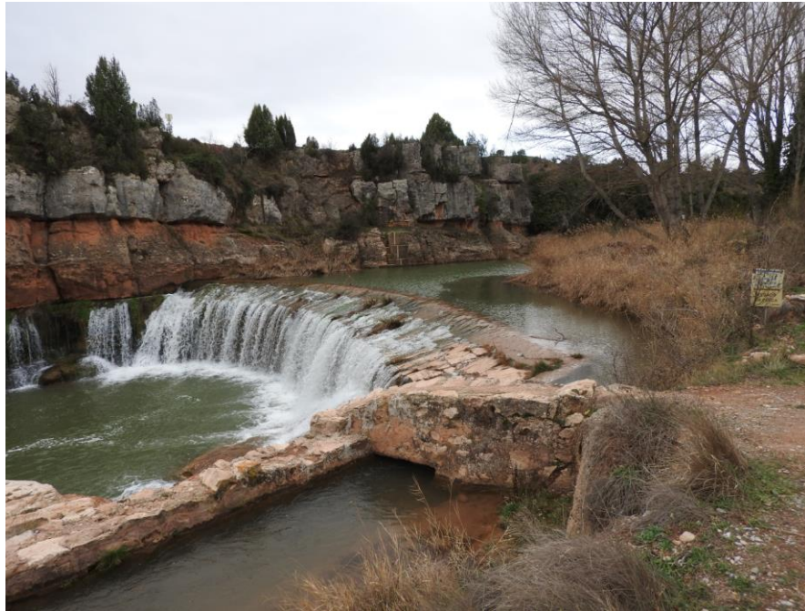
Figura 4. Imagen ejemplo de tipo de obstáculo de Salto Vertical, se trata de un azud conocido como “Carretera Mora” con código 584 en el Inventario de Azudes de la CHJ.
