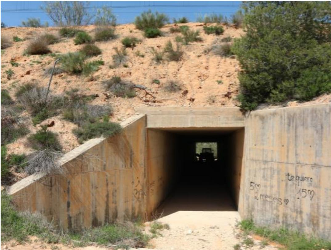
*Figura 8: Detalle de la sección para el cruce inferior de la vía del tren*
