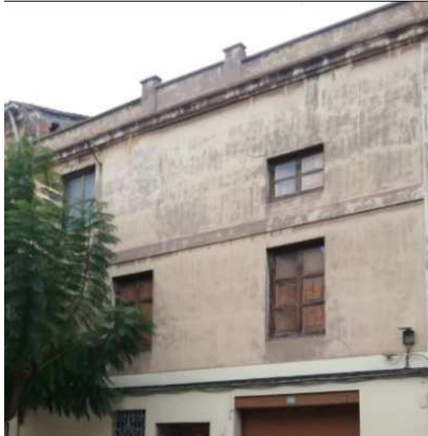
Figura 15: Imagen fachada. 2017 Fuente: Propia
