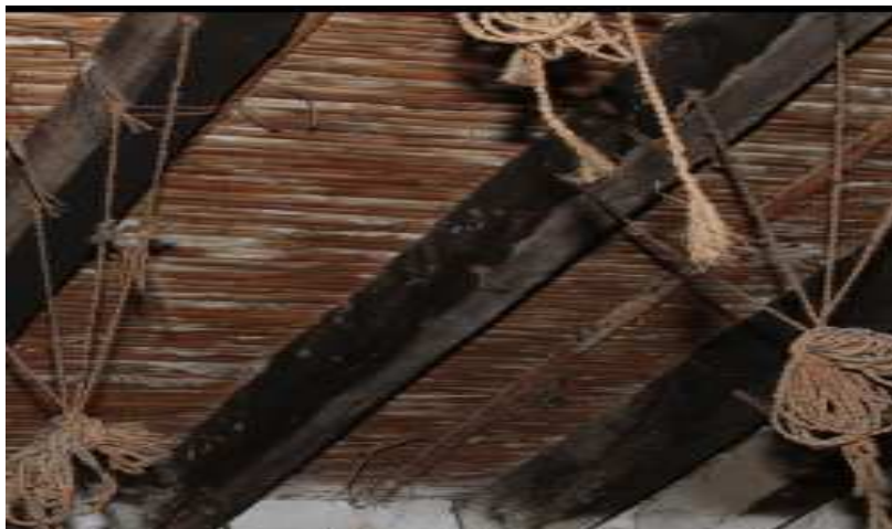
Figura 21: Detalle fotográfico de la cara interior de la cubierta inclinada. 2017.
