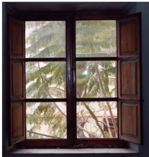
Figura 22: Carpintería de madera en vivienda. 2017 Fuente: propia
