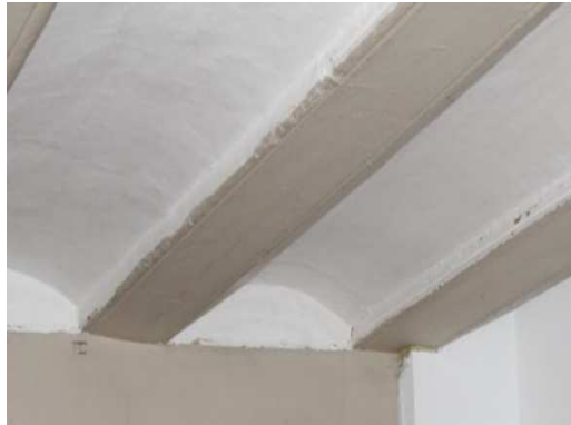
Figura 19: Forjado Horizontal. 2017. Fuente: propia
