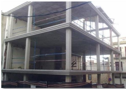
24 Estructura Hormigón armado: espaisbenfets.com
