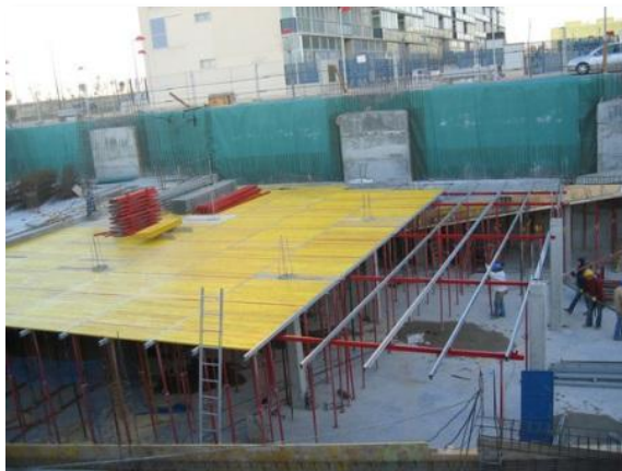
30 Encofrado forjado: www.logismarket.es
