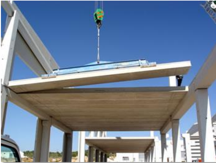
39 Losa alveolar: www.prefabricadosaljema.com
