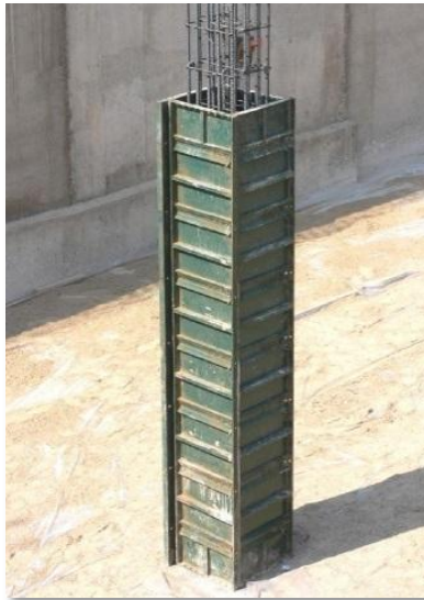
29 Encofrado pilar: aparejador.blogia.com
