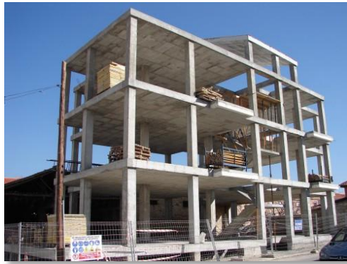
25 Estructura Hormigón armado:
