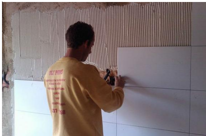
50 Colocación alicatado: www.reformasycocinas.com
