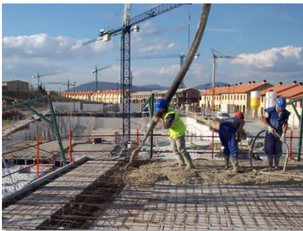
31 Vertido y vibrado hormigón: aglomeradoszabaleta.com
