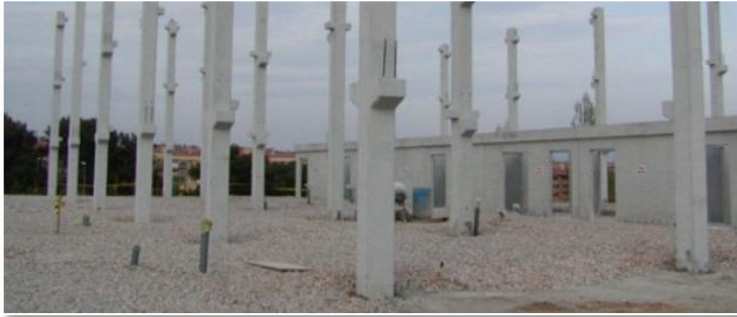
36 Pilares prefabricados: esp.prefabricatspujol.com
