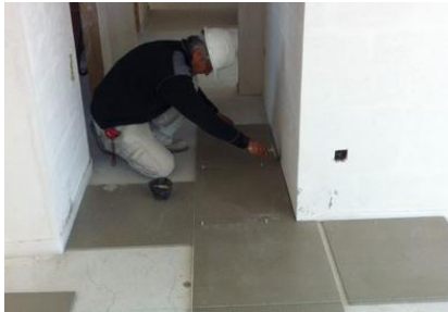
49 Colocación pavimento: www.technihomes.com
