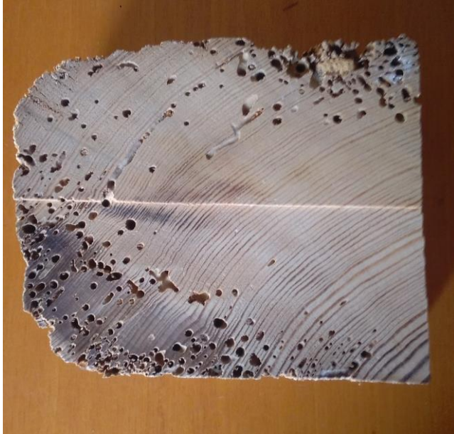
Figura 1.3. Madera degradada por carcoma fina. 2017. Fuente propia.
