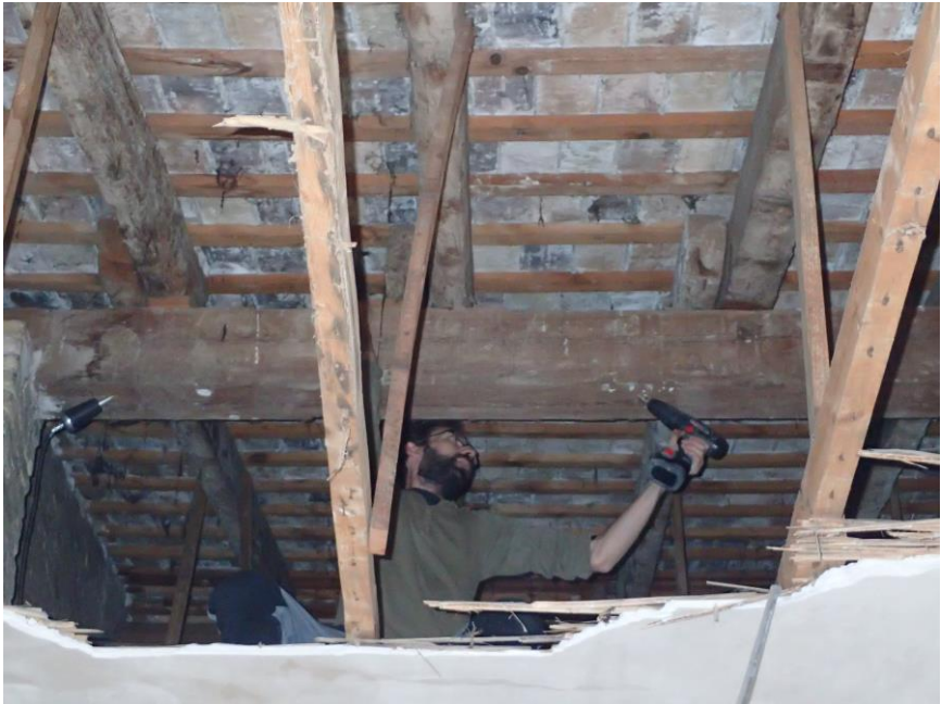
Figura 3.22. Colocación de los transductores para la medición de ultrasonidos. 2017. Fuente propia.
