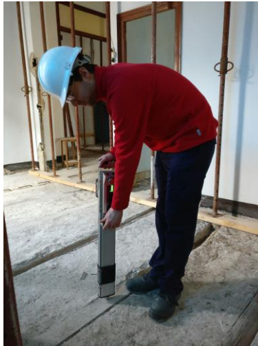
Figura AII.2. Realizando una resistografía en una de las viguetas del forjado de planta 1 en la inspección de Calle Reina nº 135. 2017. Fuente propia.
