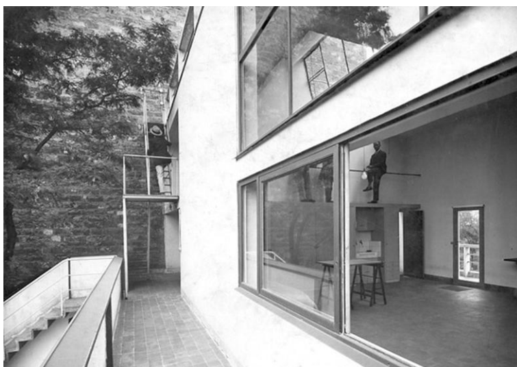
4. Casa Planeix. París 1924. Fotografía de Georges Thiriet, FLC L2(14)16. Vista tomada desde la terraza hacia la escalera exterior.
