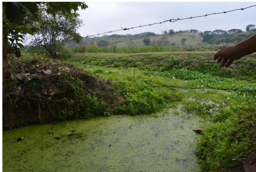
Imagen 1. Agua estancada de manera permanente en el canal interno de la finca [Fuente propia]
