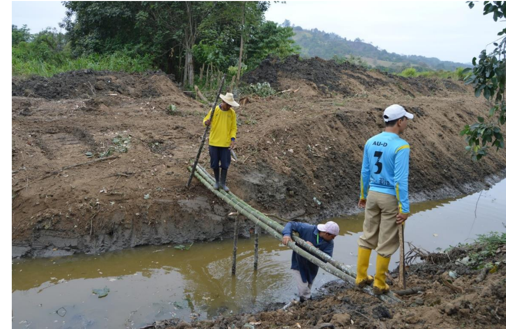
Imagen 21. Proceso de construcción de un paso a nivel una parte de la canalización existente en la finca objeto de estudio. [Fuente: propia]
