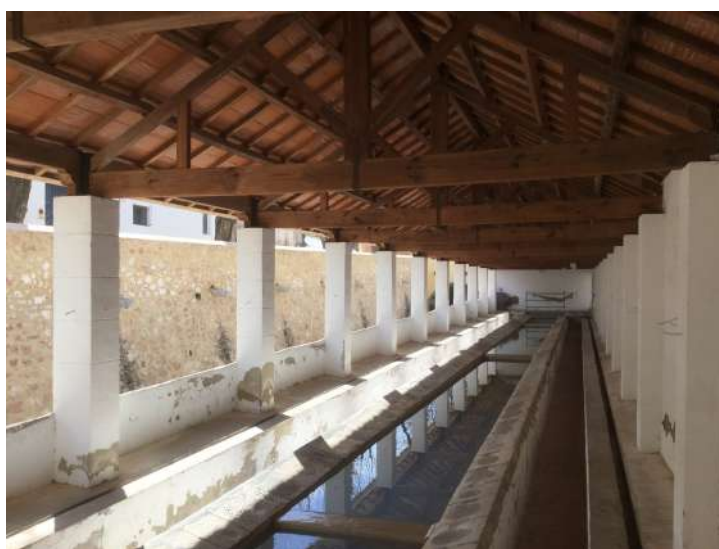
Fig. 16 - Interior del Lavadero Municipal. FUENTE: Juan B. Marco Segura.
