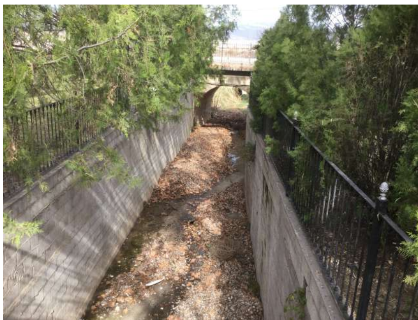
Fig. 13 - Tramo con cajeros de bloques de hormigón. FUENTE: Juan B. Marco Segura.
