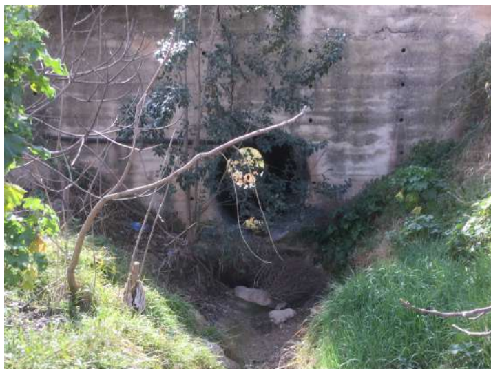
Fig. 14 - Conducto que cruza la carretera N-344 visto desde el norte. FUENTE: Juan B. Marco Segura
