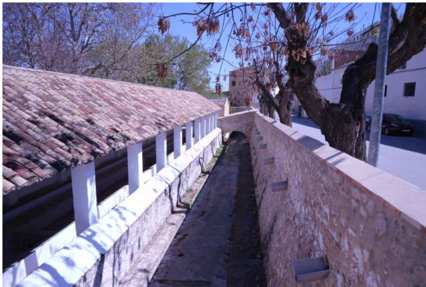
Fig. 12 - Tramo de mampostería colindante al Lavadero Municipal. FUENTE: Elaboración propia.
