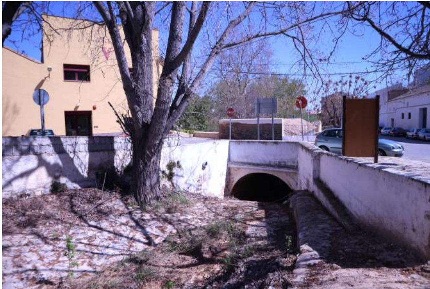
Fig. 11 - Embocadura y labio del encauzamiento urbano. FUENTE: Elaboración propia.
