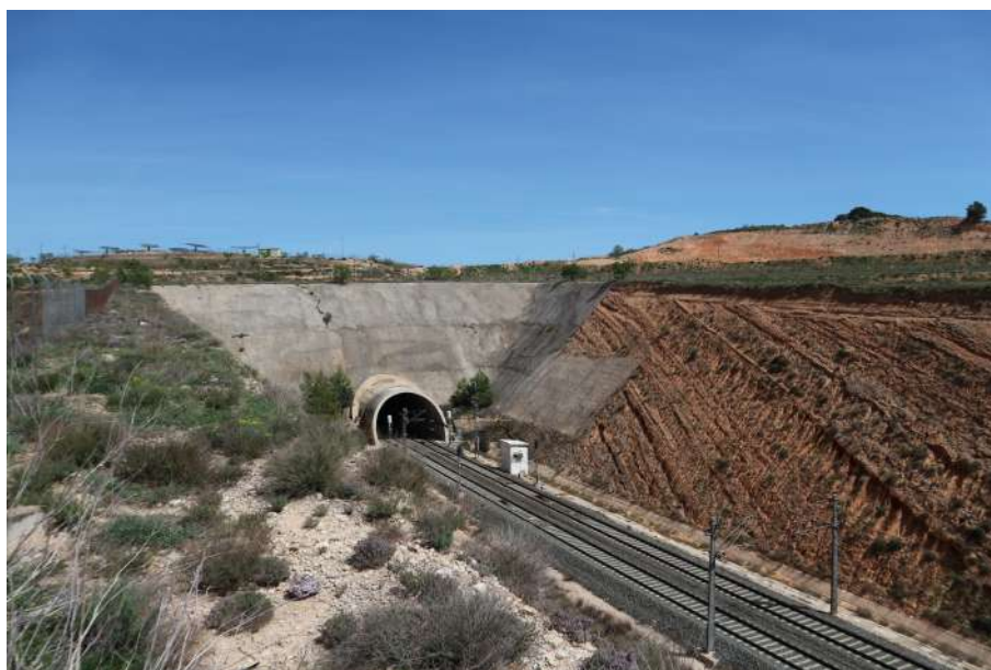
Fig. 2 - Inicio de la zanja del ferrocarril que atraviesa la Foia de Manuel. FUENTE: Elaboración propia.
