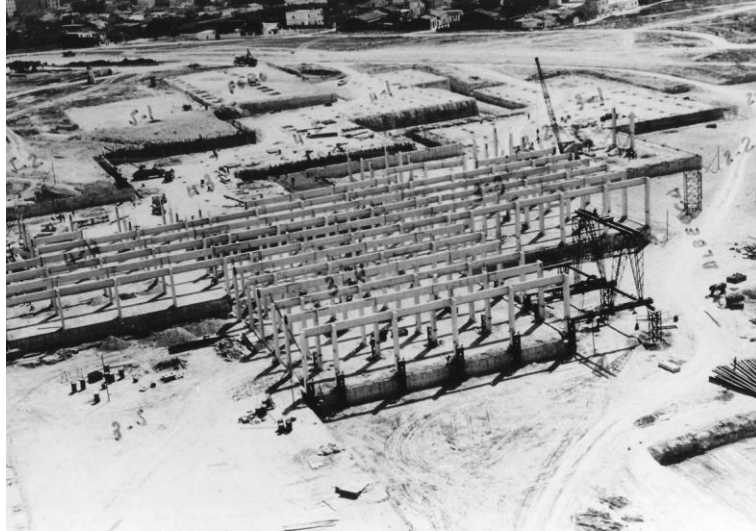
9. Construcción de la estructura de las lonjas de Feria de Valencia.
