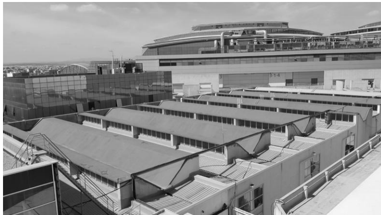
10. Cubierta del Foro Norte, única lonja existente.
