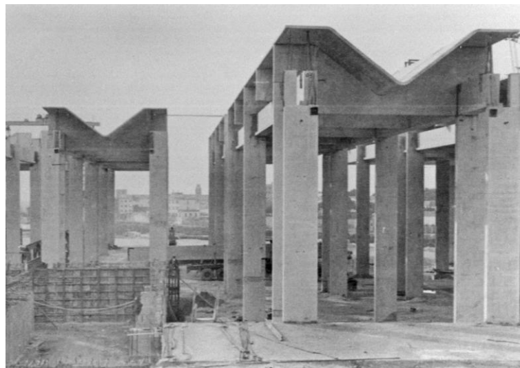
7. Construcción de las losas en V en Feria de Valencia.
