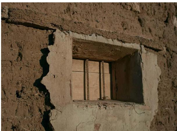
*Ilustración 145: Pérdida de revestimiento del muro de adobe en una barraca de Alboraiá. Fuente: Barracas del litoral mediterráneo.*
