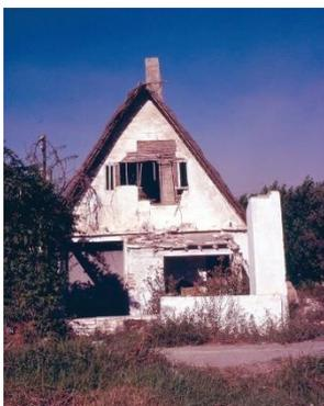
Ilustración 152: Diversas patologías en fachada, desprendimiento del penal y volada del penal con el dintel de la ventana.
