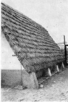
*Ilustración 51: pilastras que ayudan a acodar el muro para que resista mejor los empujes de cubierta y evitar el pandeo. Nótese como se ordena el borró de cubierta dando un aspecto artístico muy usado con las cubiertas de paja del centro y norte de Europa.*
