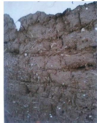
*Ilustración 156: Detalle de degradación del muro por salpicaduras. Fuente: Barracas del litoral mediterráneo.*
