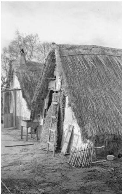
Ilustración 144: Barracas típicas valencianas ca.1950. Se puede observar el solape del borro y el remate de cumbreta.
