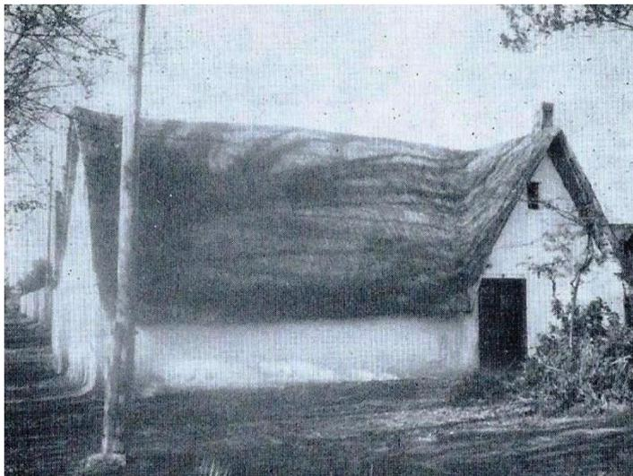
*Ilustración 57: Barracas en perpendicular, notese que encima se han unido por la cubierta. Barraca de Trabuc, Sedaaví. Fuente: [barracavalenciana.blogspot.com.es](http://barracavalenciana.blogspot.com.es)*
