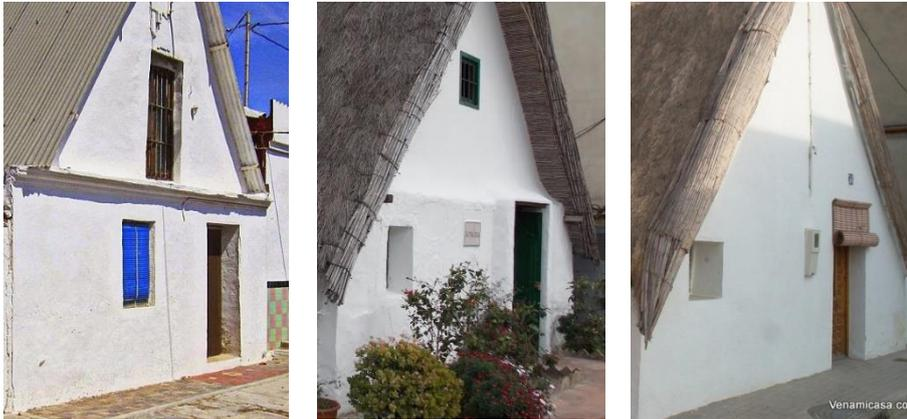
*Ilustración 141: tipos de encuentro del muro con el penal: Volada de penal - escalon - enrasado.*
