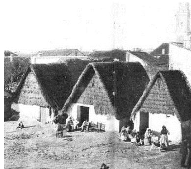
*Ilustración 51: El murete del hastial no ha sido enjalbegado y queda con la caña o carrizo visto. Muchas culturas precolombinas tienen construcciones muy similares.*
