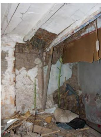
*Ilustración 155: Interior barraca. Detalle refuerzo de muro con troncos de árbol y forjado de cañizo (Pastor 2011). Un edificio patrimonial de la huerta valenciana, La barraca.*
