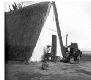
*Ilustración 51: Barraca que carece de paredes, levantando la cubierta directamente apoyada sobre el suelo.*
