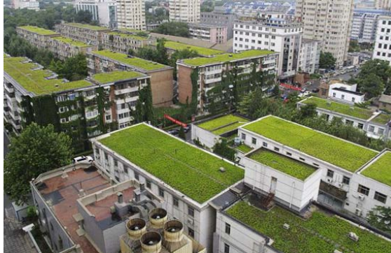
Ilustración 27. Cubierta ajardinada. 2010. http://www.certificadosenergeticos.com
