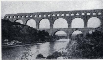
Aqueduc du Gard.
