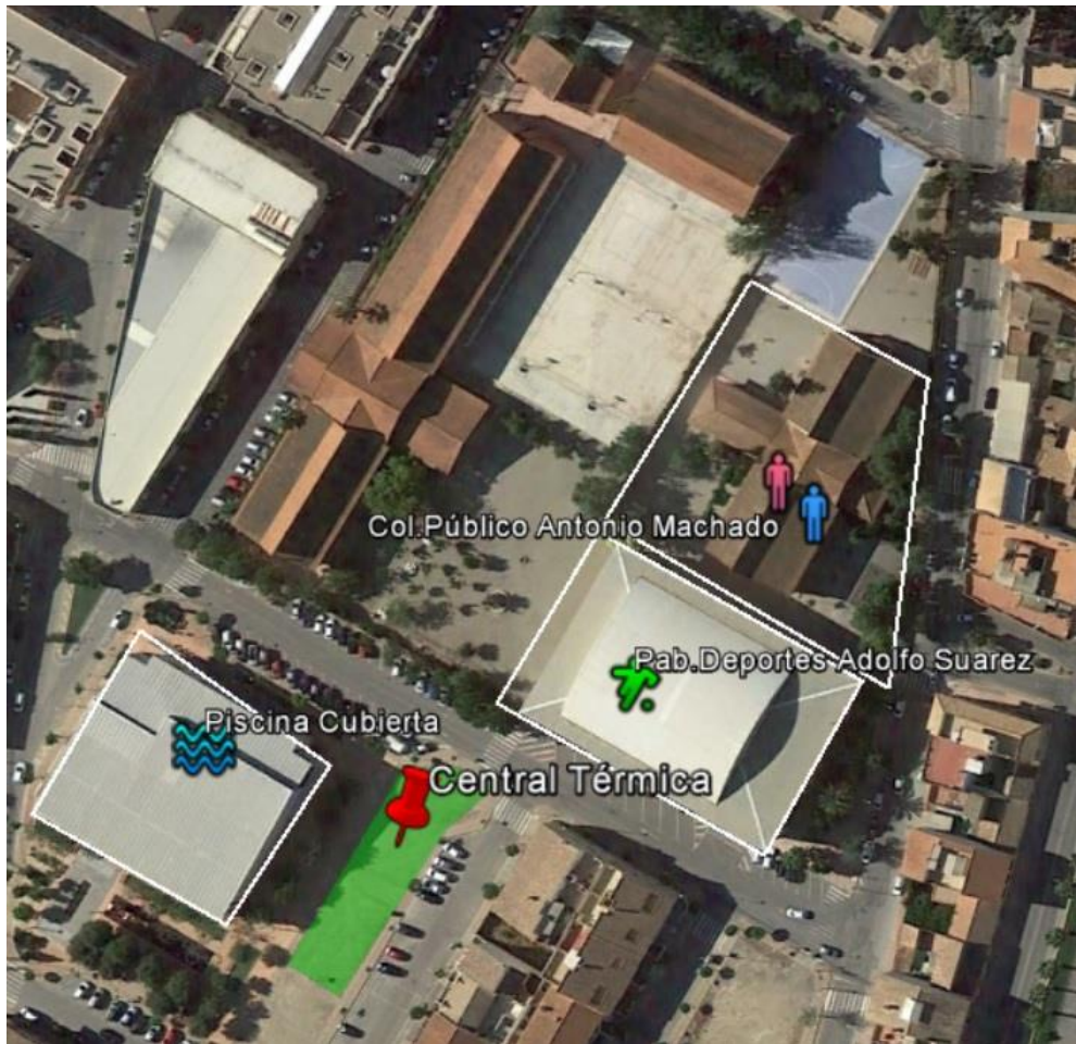
Fig.12. Vista aérea de la parcela de ubicación de la Central Térmica. Fuente: Google Earth.
