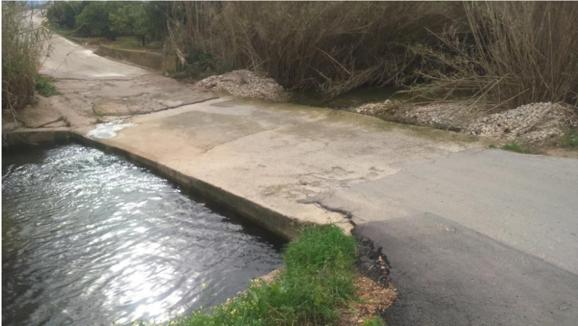
FIGURA 30: Presa Badén en Benifairó de la Vall d'igna (AZUD 0360).
