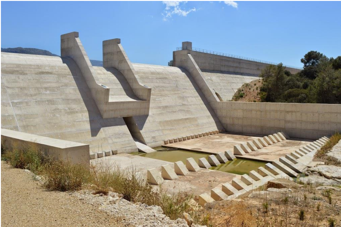
FIGURA 6: Presa de Terrateig (Azud).
