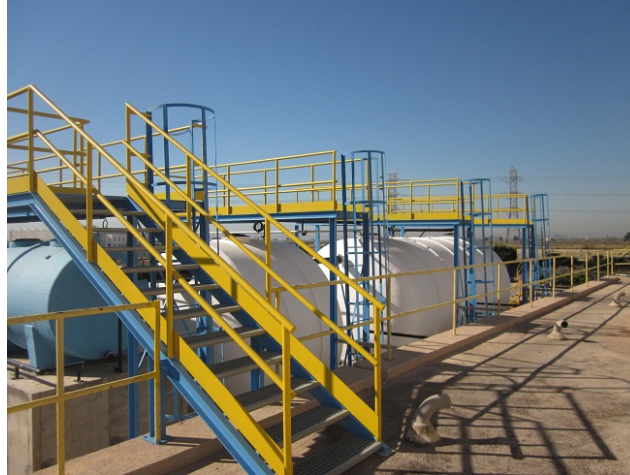
Ilustración 5. Acceso a pasarela.
