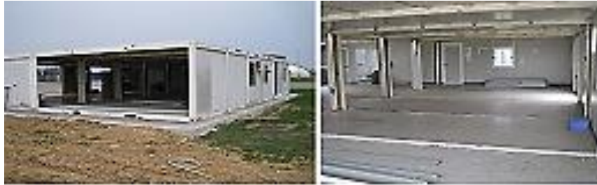
Ilustración 5: Edificio prefabricado ya instalado Fuente: ONU
