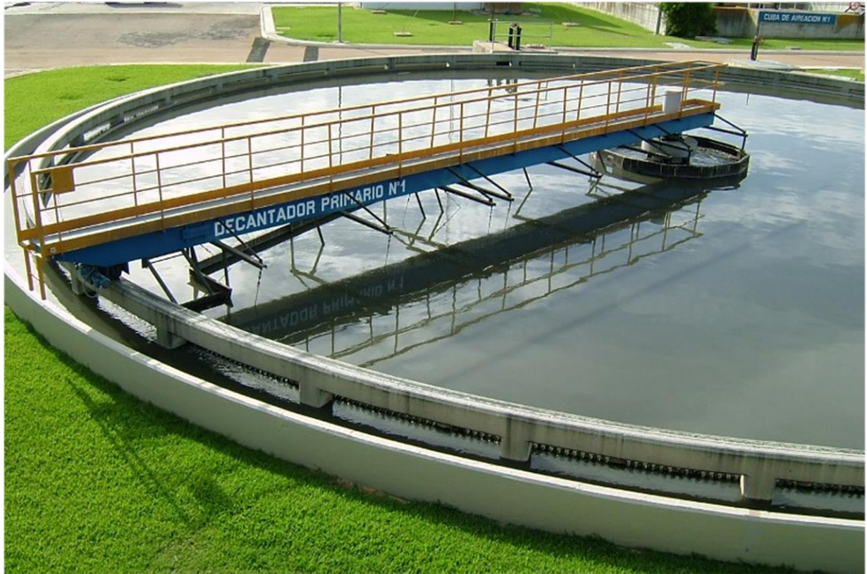
Figura 2: Decantador primario (Fuente: www.massscience.com )
