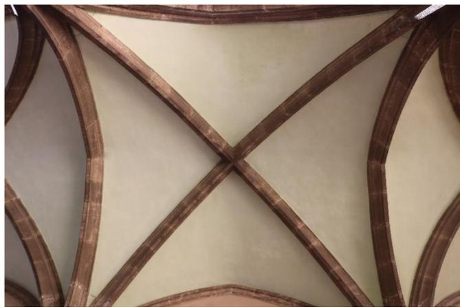
Fig.27\_ *Bóveda de crucería de una de las galerías del claustro bajo.*
