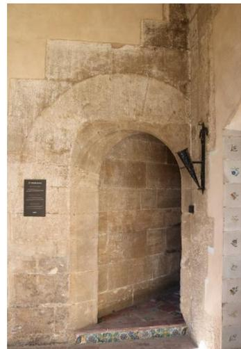
Fig.9\_Vano en esviaje sobre el muro en el acceso a la cocina.
