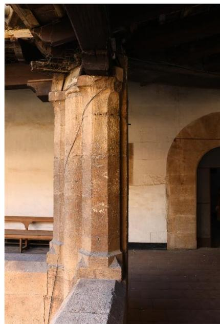
Fig.28\_ *Detalle de la columna ochavada en esquina.*
