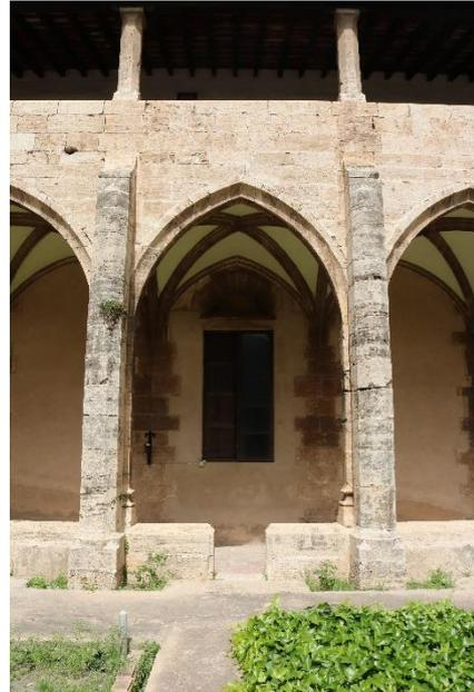
Fig.26\_ *Conjunto del arco ojival, pilastras y muro.*
