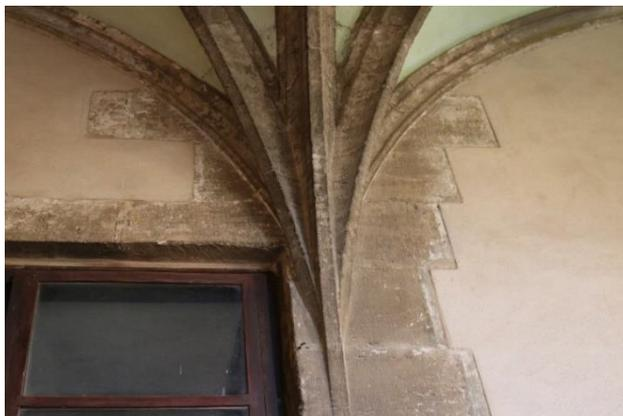
Fig.32\_ Detalle enjarje muro-bóveda.
