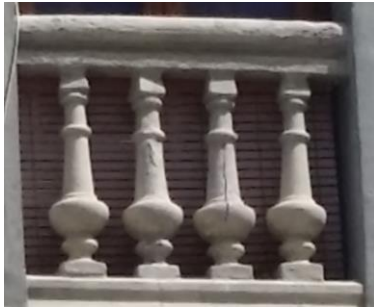
Figura 51 y 52 Balaustrada de la izquierda fisurada y la de la derecha erosionada. Febrero 2017.
