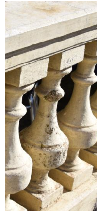
Figura 51 y 52 Balaustrada de la izquierda fisurada y la de la derecha erosionada. Febrero 2017.
