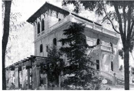
Figura 16. Villa Rosa, construida en 1910 por el arquitecto Ricardo Marcos Bauzá. Extraída de historias-matritenses.blogspot.com.es/2009/09/villa-de-zacarias-homs-o-villa-rosa.html . El 19/06/2017.
