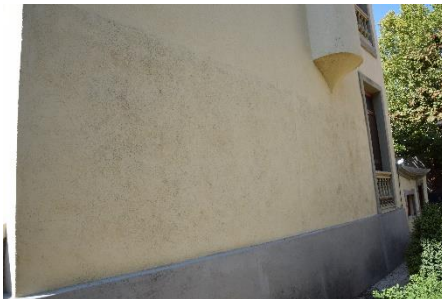
Figura 48. Fachada Noreste. Febrero 2017.
