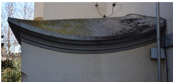
Figura 50. Cubierta “Casa de Muñecas”. Febrero 2017.
