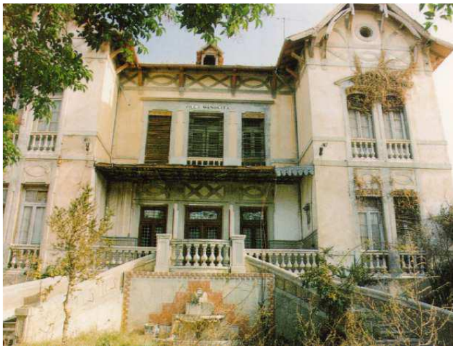
Figura 8. Villa Manolita antes de la rehabilitación. Facilitada por Pablo, fotógrafo del periódico municipal “El Termino”. Año 2000.
