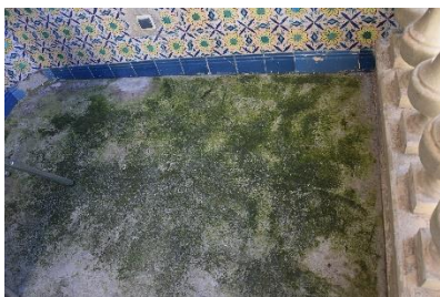
Figura 49. Suelo de la terraza. Febrero 2017.
