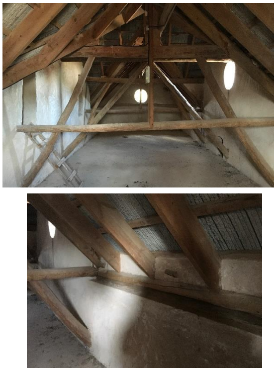
Figura 42 y 43. Detalle de cubierta de madera. Febrero 2017.
