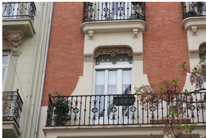
Fig. 2.30. Imagen fachada principal (Planta 2ª) Sorní nº14. Fuente propia.
