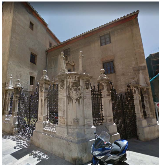
Fig. 2.7. Imagen de verja de cerramiento del Colegio del Patriarca. Fuente: Buscador Google
