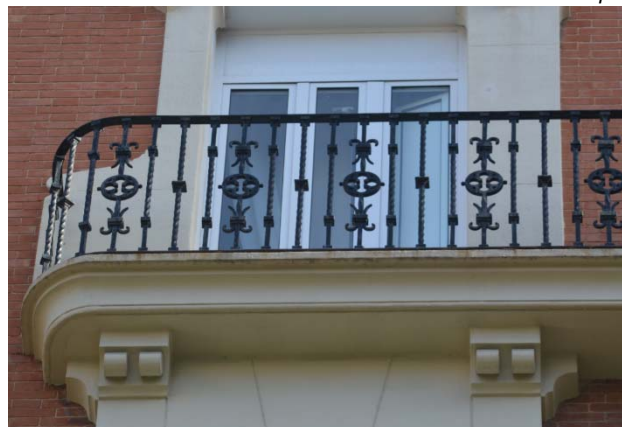
Fig. 2.42. Imagen de barandilla de balcón. Fuente propia.
