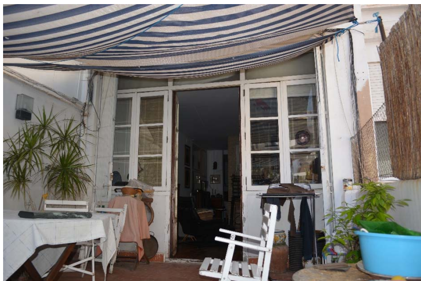
Fig. 2.34. Imagen fachada posterior (Planta 1ª) Sorní n°14. Fuente propia.
