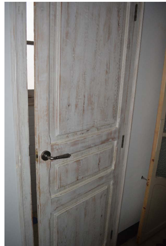
Fig. 2.80. Imagen de carpintería interior de vivienda. Fuente propia.
