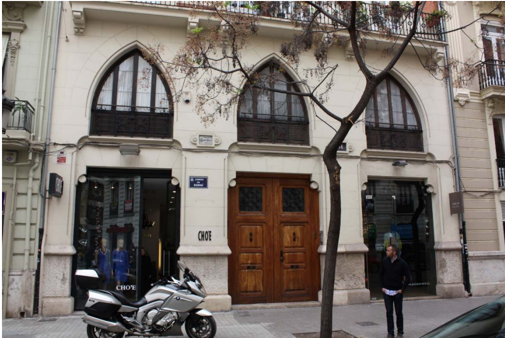
Fig. 2.29. Imagen fachada principal (Planta Baja) Sorní nº14. Fuente propia.
