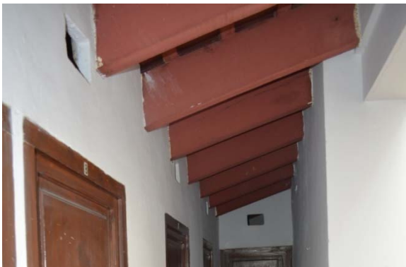
Fig. 2.86. Imagen de estructura de cubierta del edificio. Fuente propia.
