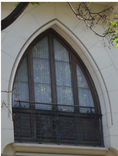
Fig. 2.39. Imagen de ventana de planta 1ª. Fuente propia.
