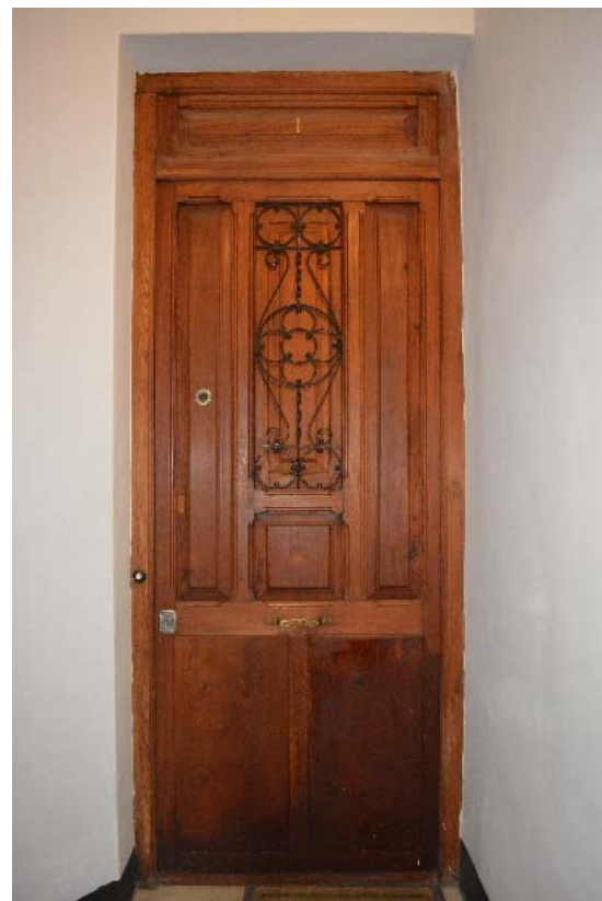
Fig. 2.93. Imagen de puerta de acceso a vivienda. Fuente propia.
