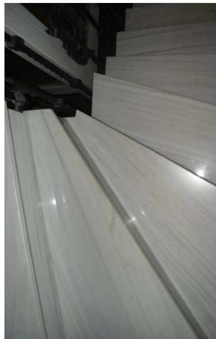
Fig. 2.54. Imagen de escalera compensada (zaguán). Fuente propia.
