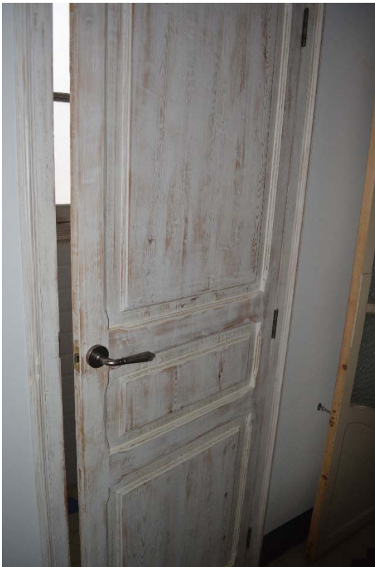
Fig. 2.92. Imagen de carpintería interior de vivienda. Fuente propia.
