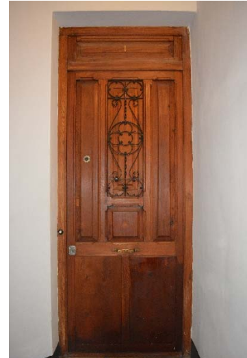
Fig. 2.41. Imagen de puerta de acceso a vivienda. Fuente propia.
