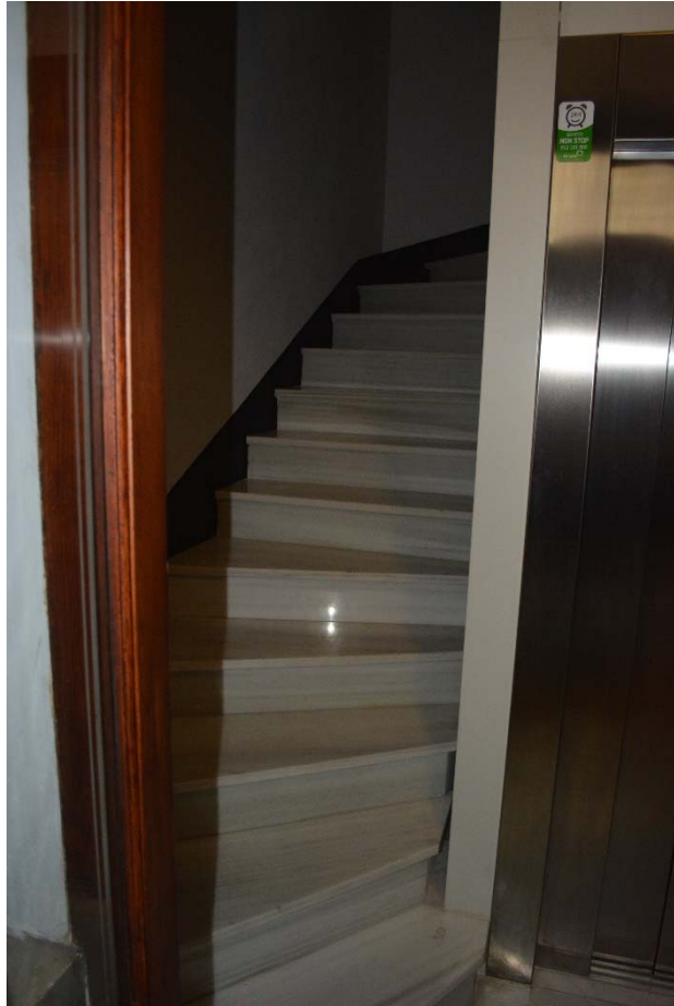
Fig. 2.52. Imagen de escalera compensada (zaguán). Fuente propia.
