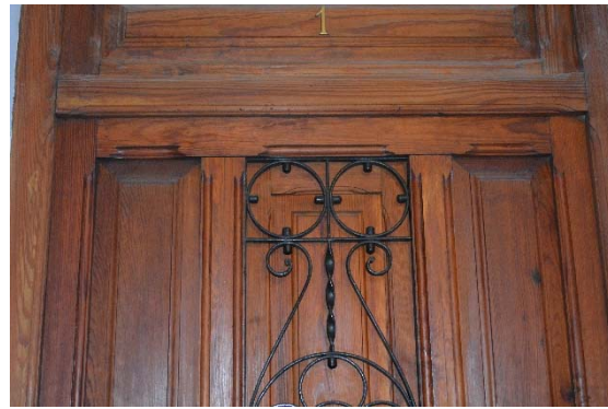
Fig. 2.64. Imagen de detalle de puerta de vivienda. Fuente propia.
