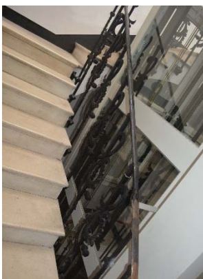
Fig. 2.95. Imagen de escalera (Planta 4ª). Fuente propia.
