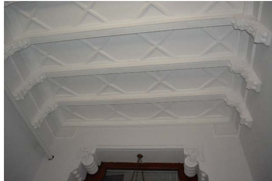
Fig. 2.48. Imagen del techo del zaguán. Fuente propia.
