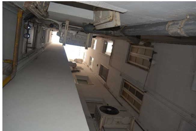
Fig. 2.57. Imagen vertical del patio de luces. Fuente propia.
