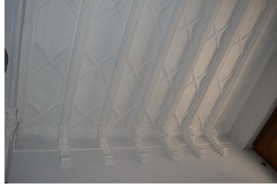
Fig. 2.47. Imagen del techo del zaguán. Fuente propia.
