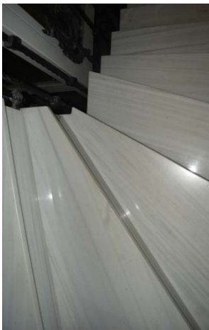
Fig. 2.94. Imagen de escalera compensada (zaguán). Fuente propia.
