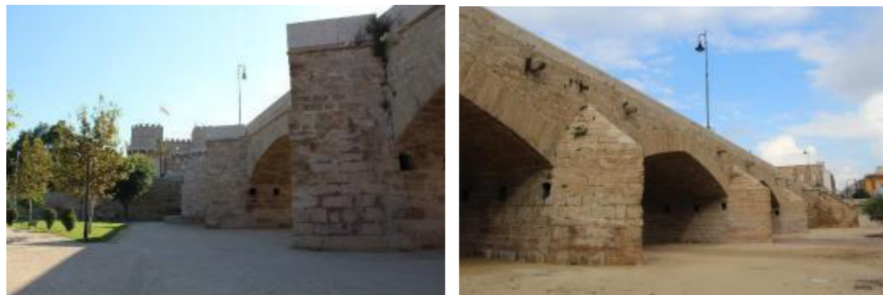
Figuras 4 y 5. Puente de Serranos (izquierda) y Puente de la Trinidad (derecha). Fuente: Fotografías propias de los autores.
